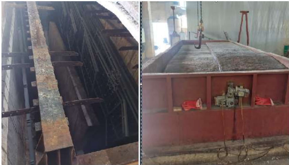
Slika 4.9 Komora za sušenje čelika
