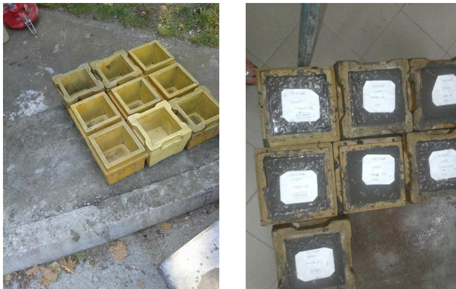
Slika 19 Prazni kalupi za probna tijela i ispunjeni svježim betonom
