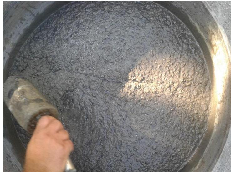
Slika 32 Bojanje svježeg betona i isplivavanje mješavine na površinu
