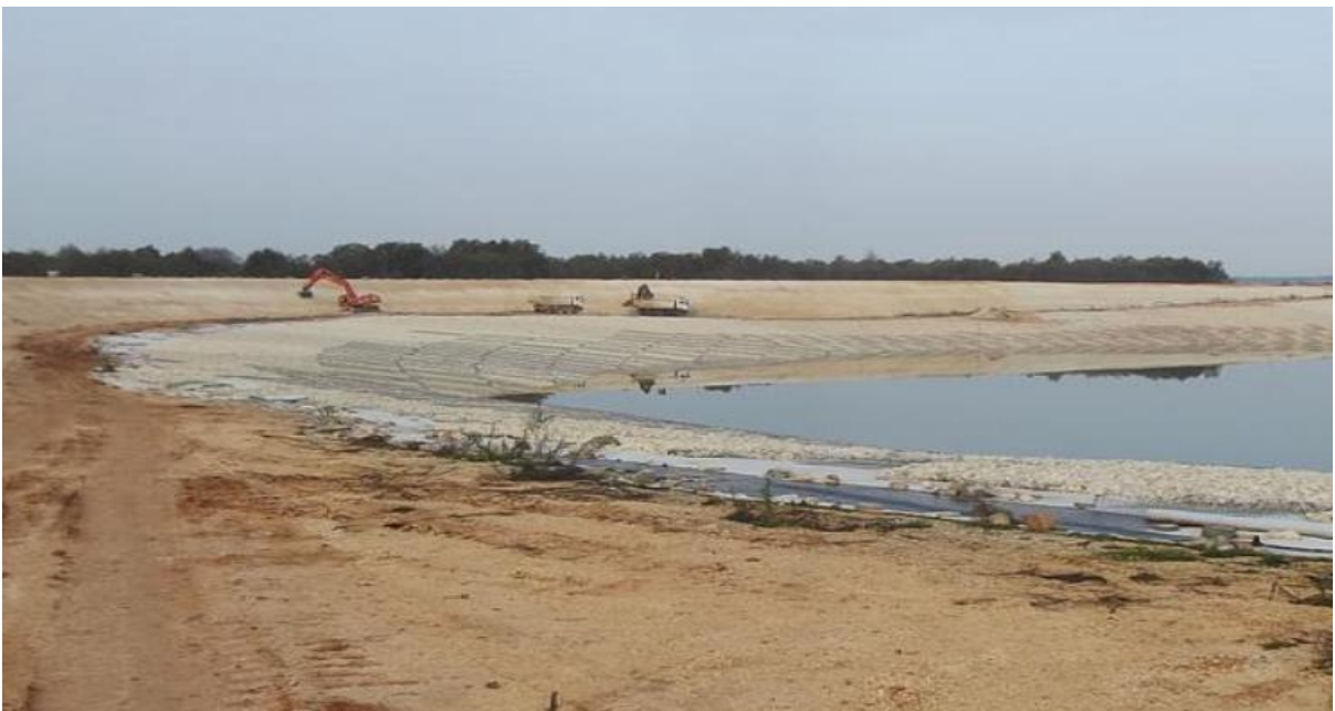
Slika 2.2. Akumulacijsko jezero Bakranjuša prilikom izgradnje
