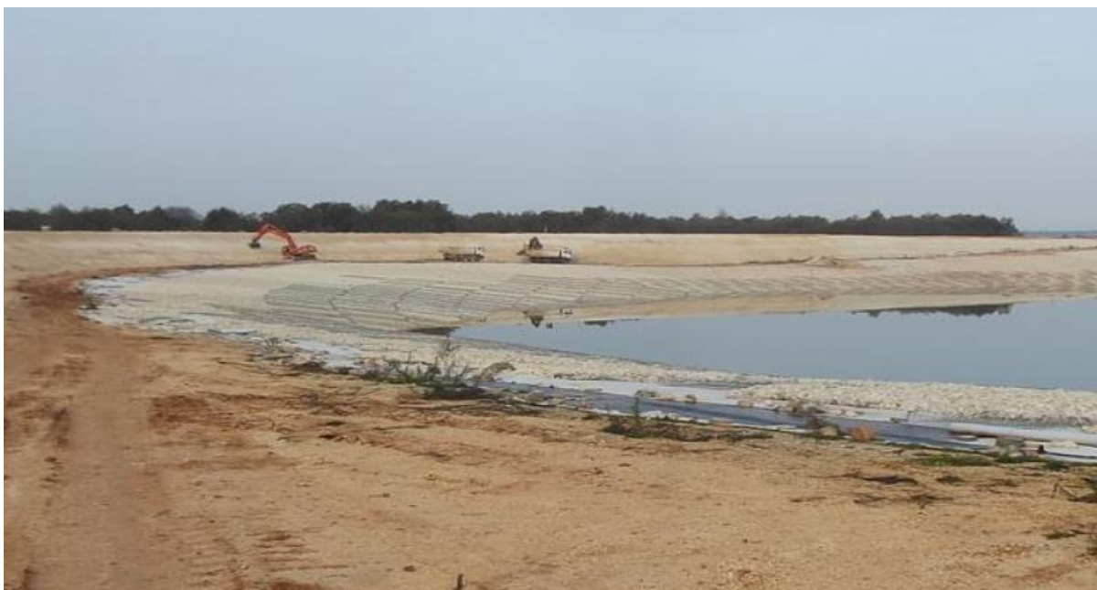
Slika 2.2. Akumulacijsko jezero Bakranjuša prilikom izgradnje
