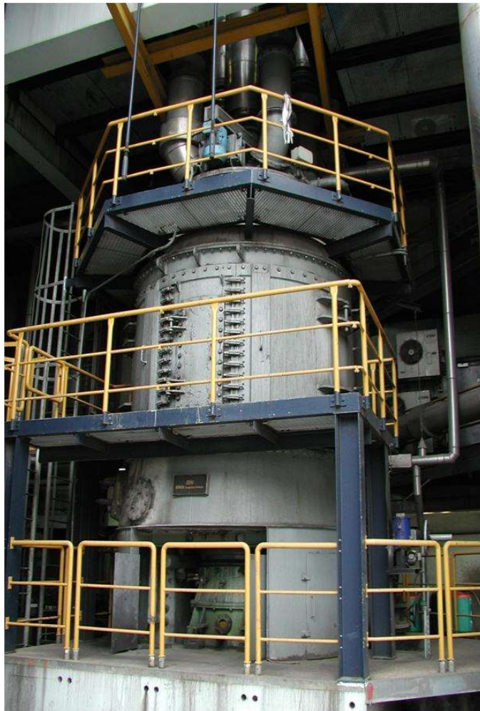
Slika 1.1. Kuglasti mlin TE Plomin 2
