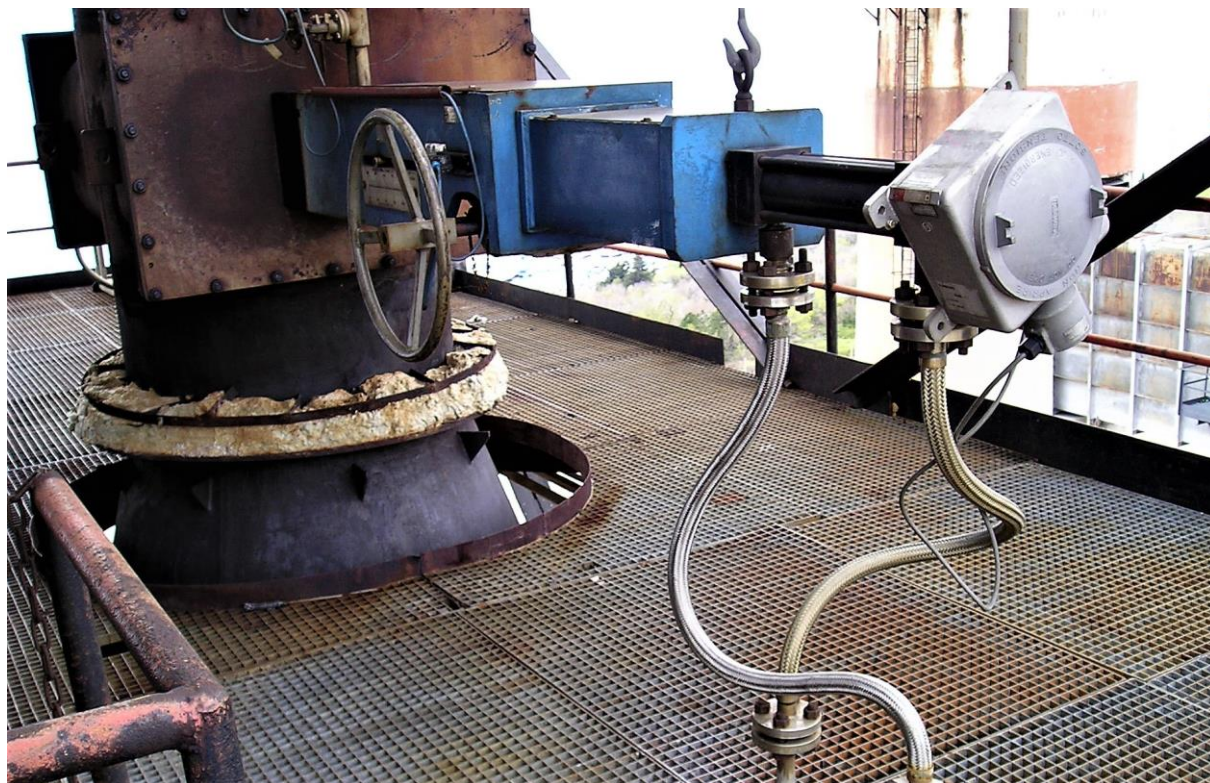
Slika 2-1 Hidraulički cilindar spojen na klizni ventil
