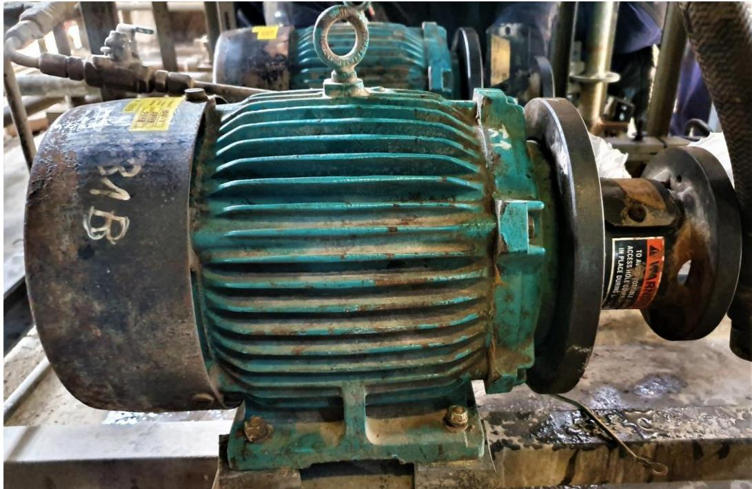
Slika 3-6 Elektromotor hidrauličkog agregata
