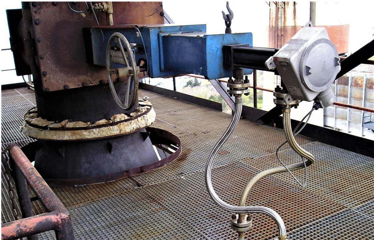
Slika 2-1 Hidraulički cilindar spojen na klizni ventil
