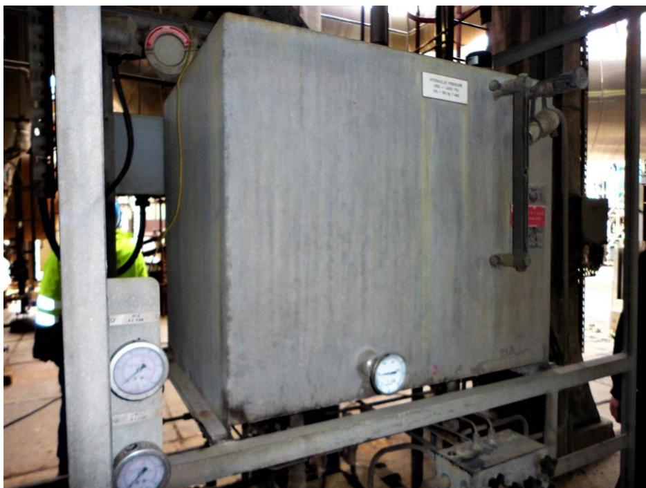
Slika 3-7 Spremnik ulja hidrauličkog agregata
