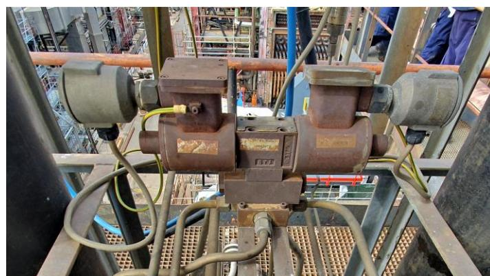
Slika 3-12 Elektromagnetni ventil
