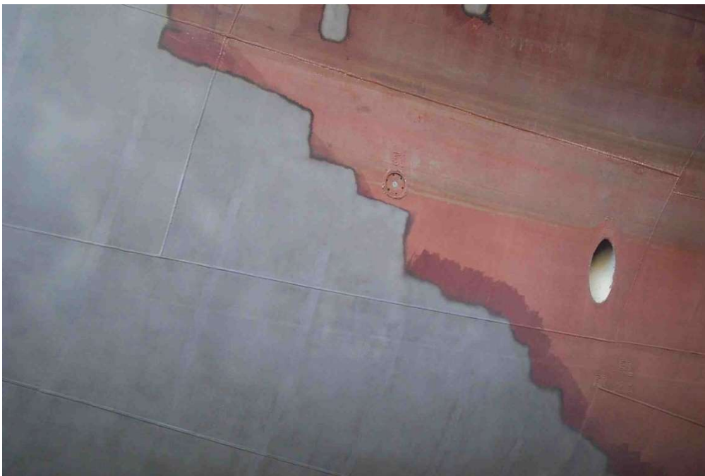
Slika 2-10. Opjeskarena površina spremna za bojenje. Izvor: autor
