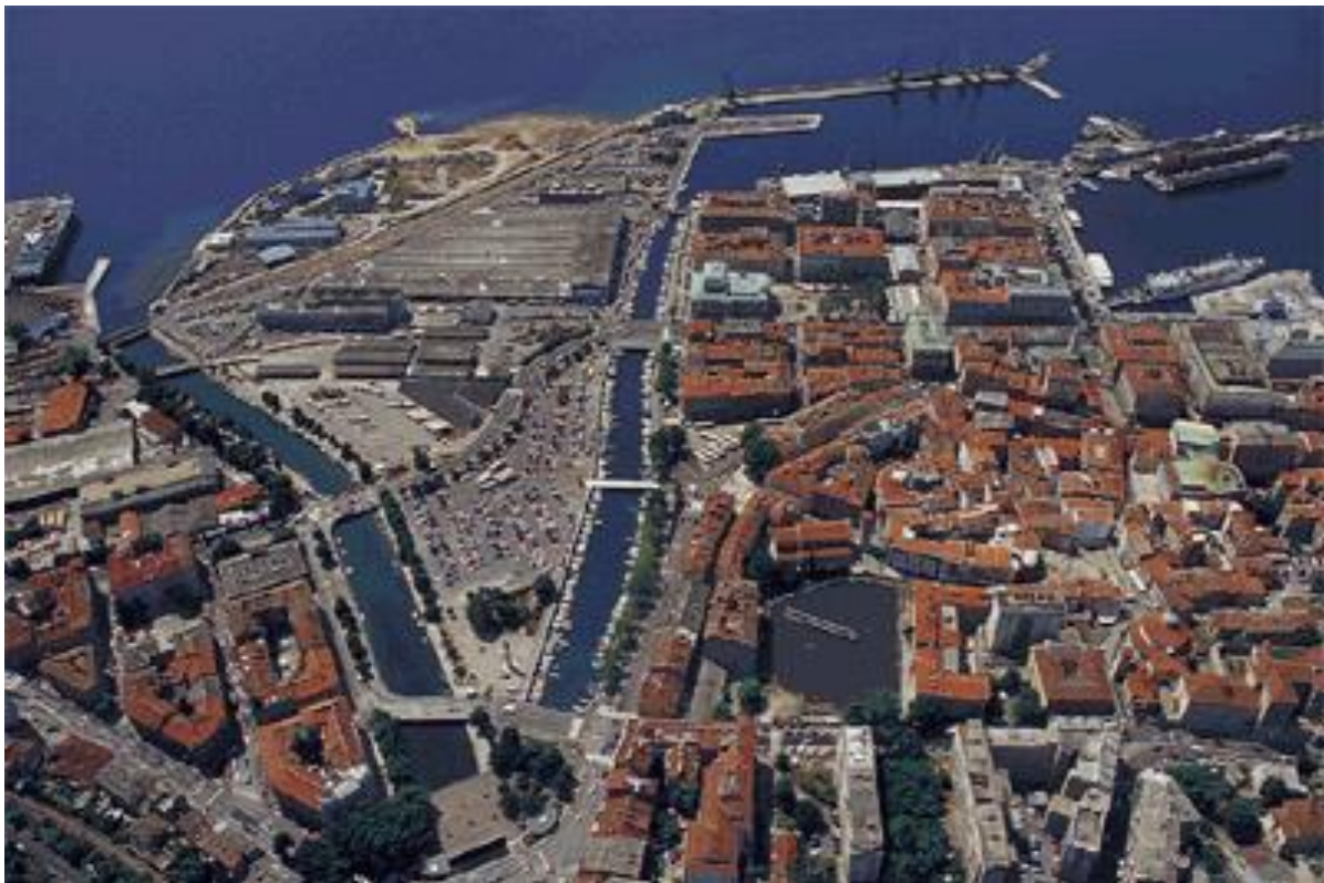
SLIKA 3. UREĐAJ ZA PROČIŠĆAVANJE OTPADNIH VODA RIJEKA ( KOMUNALNO DRUŠTVO VODOVOD I KANALIZACIJA, 2015 )
