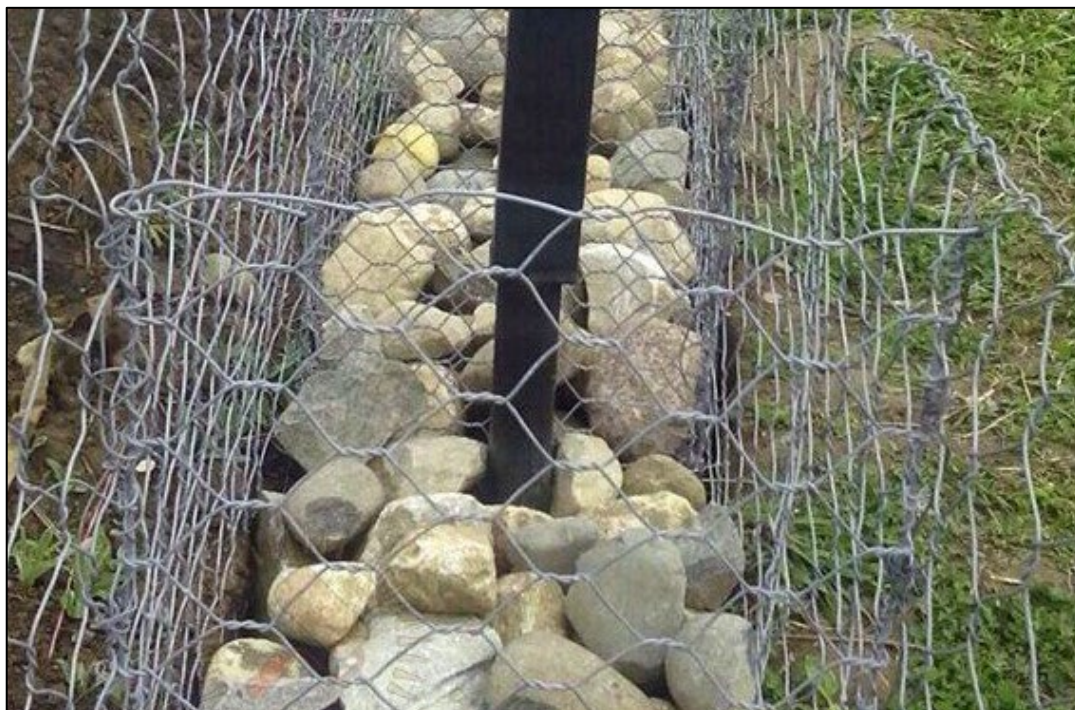
Slika 7.6. Višestruko pletena mreža gabiona [96]
