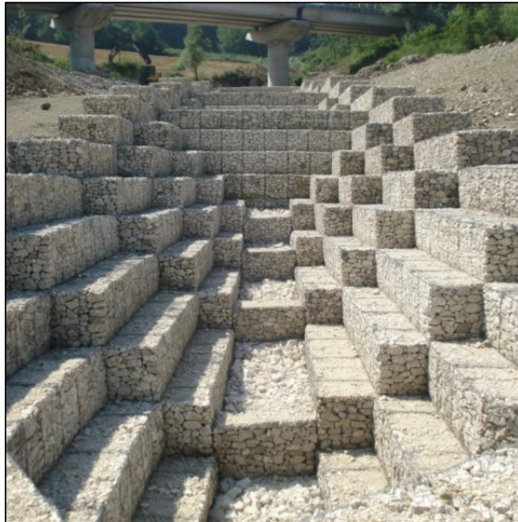
Slika 7.4. Odvodni kanali stabilizirani pomoću gabiona [94]
