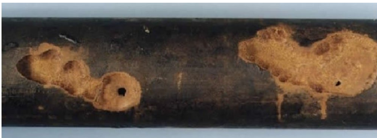
Slika 5.29. Tipičan primjer korozije lutajućih struja [60]
