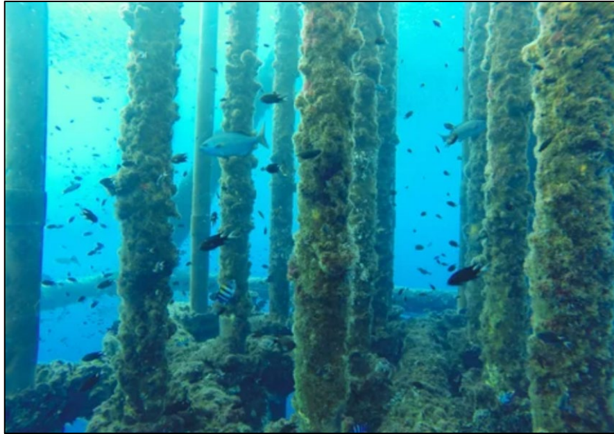
Slika 4.14. Biološko obrastanje na cijevima u moru [26]
