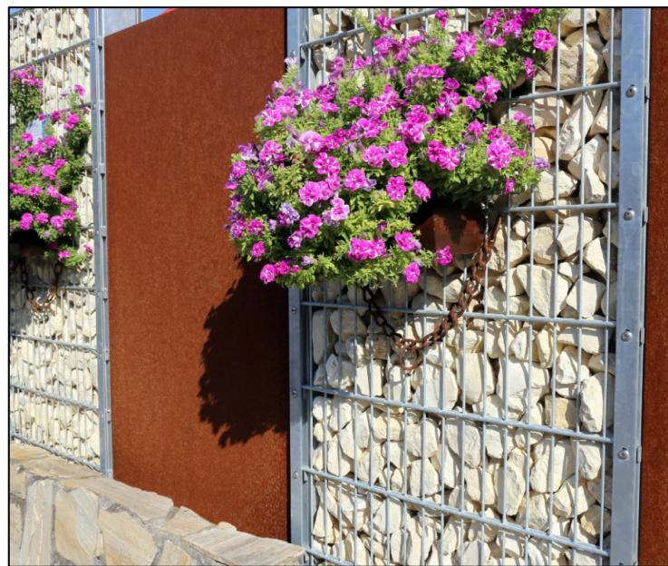
*Slika 7.5. Ograda u kombinaciji gabiona i lima od COR-TEN® čelika [95]*
