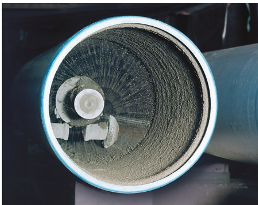
Slika 6.20. Postavljanje betonske prevlake na unutarnju stranu cjevovoda [83]
