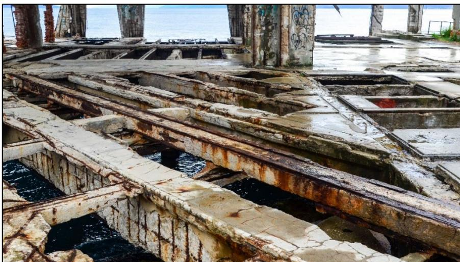
Slika 4.7. Korozija konstrukcije lansirne stанице Torpedo u morskoj atmosferi
