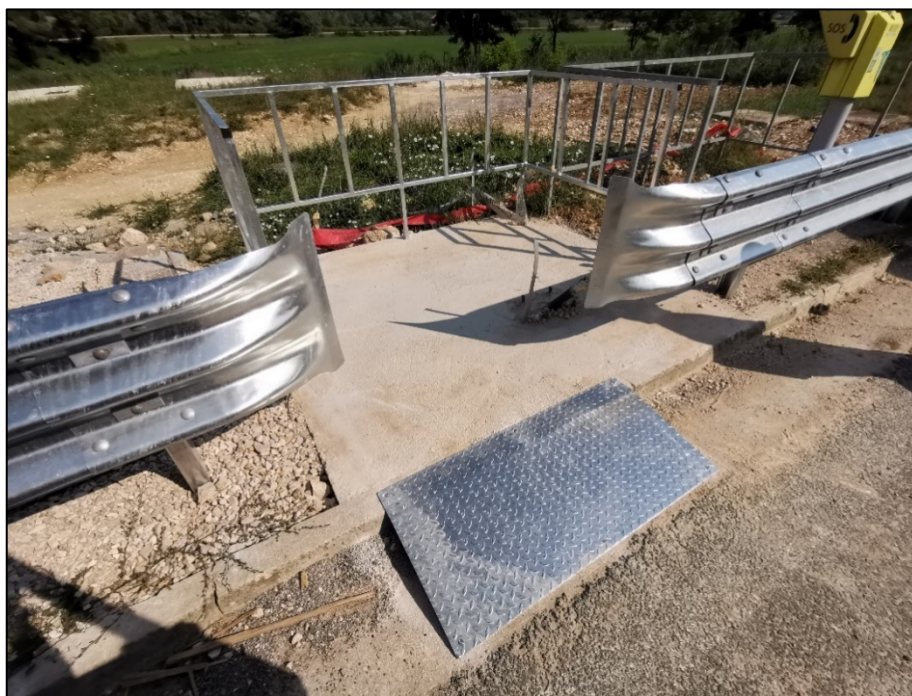
Slika 6.16. Pocinčane odbojne i zaštite ograde te pristupni limovi na SOS proširenju [11]
