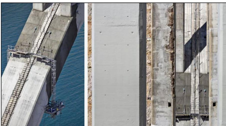
Slika 4.8. Održavanje armirano-betonskih elemenata mosta Maslenica [21]
