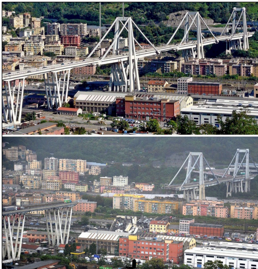
Slika 2.5. Rušenje vijadukta Polcevera (poznat i kao most Morandi u Genovi) [13]
