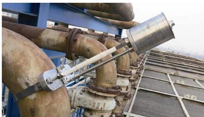
Slika 4.26. Mrežno ultrazvučno ispitivanje korozije na koljenu cjevovoda [39]
