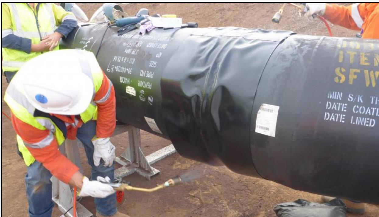
Slika 6.24. Bitumenizacija zavarenog spoja plinovoda [90]
