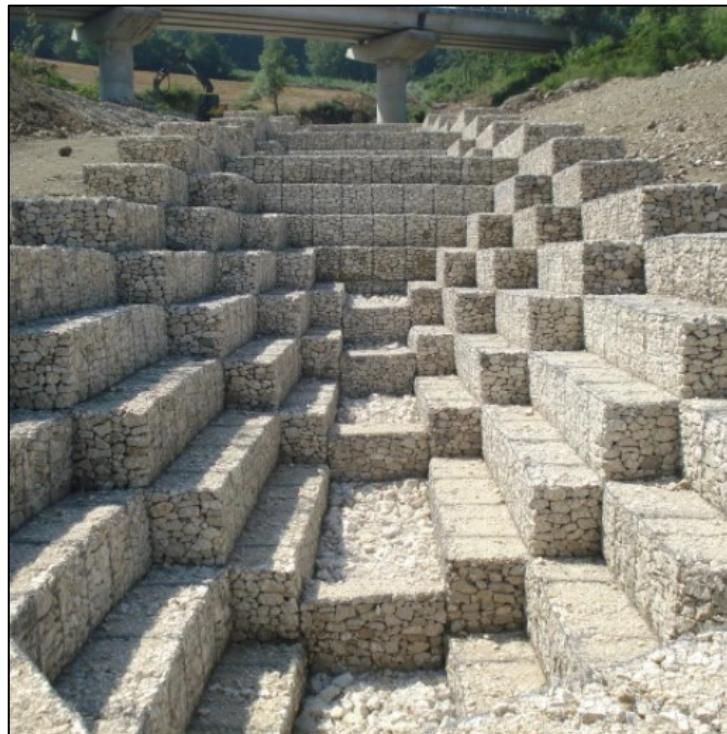
*Slika 7.4. Ovodni kanali stabilizirani pomoću gabiona [94]*
