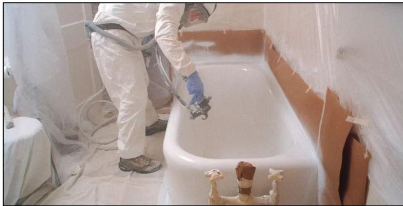
Slika 6.21. Restauracija kade od lijevanog željeza emajliranjem [85]
