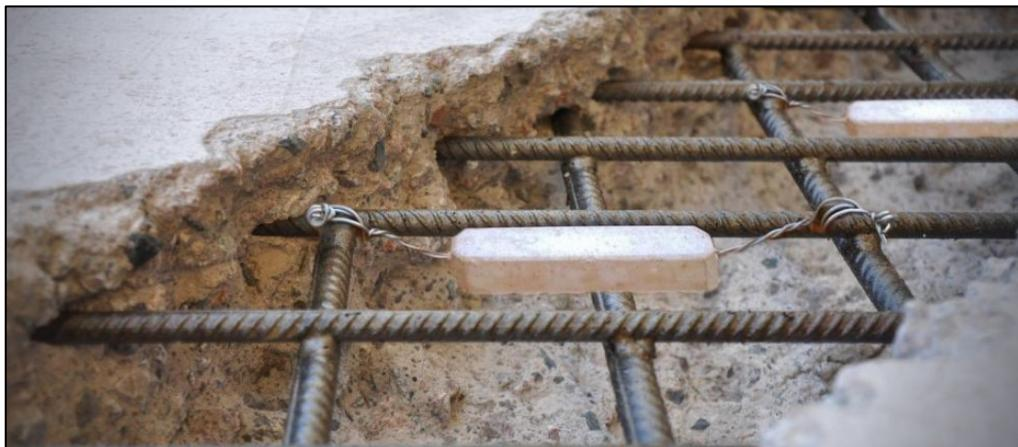
*Slika 6.7. Katodna zaštita čelične armature u armiranom betonu cinkovim polugama [69]*
