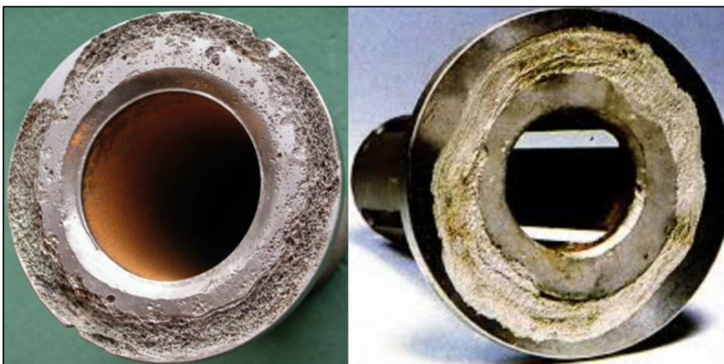
Slika 5.7. Korozija prirubnica s brtvom [43]
