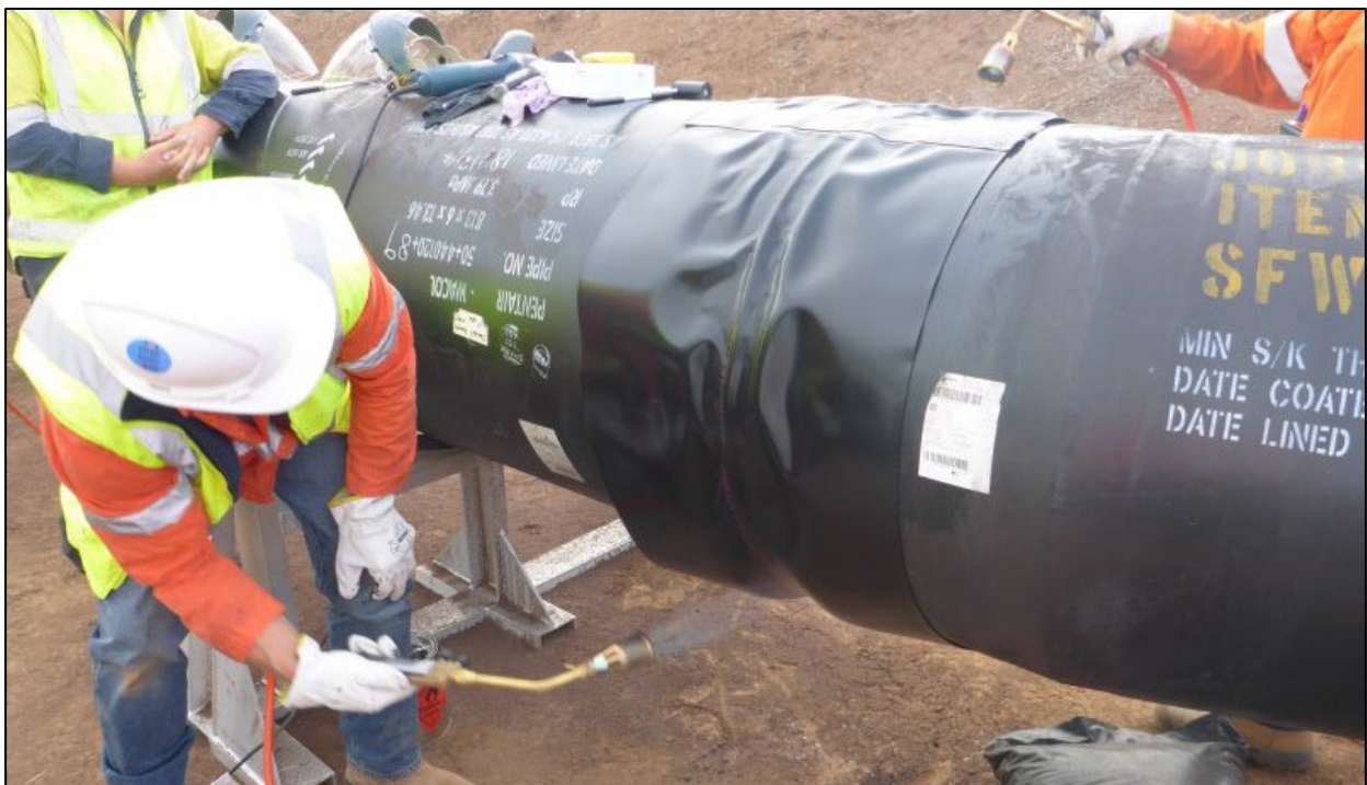
Slika 6.24. Bitumenizacija zavarenog spoja plinovoda [90]
