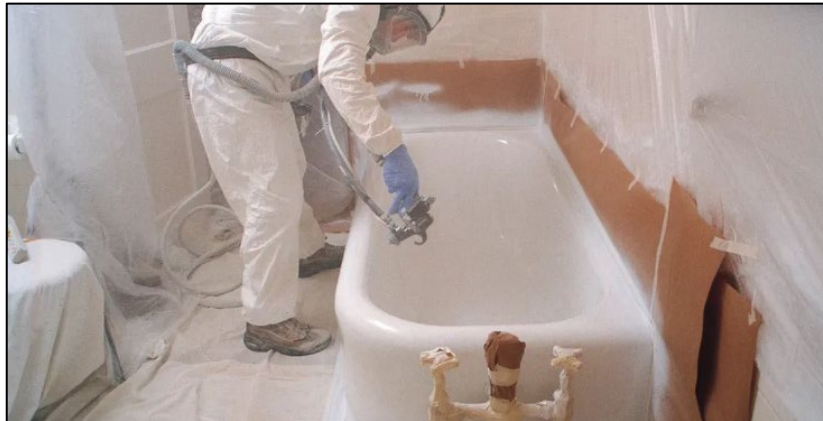
Slika 6.21. Restauracija kade od lijevanog željeza emajliranjem [85]
