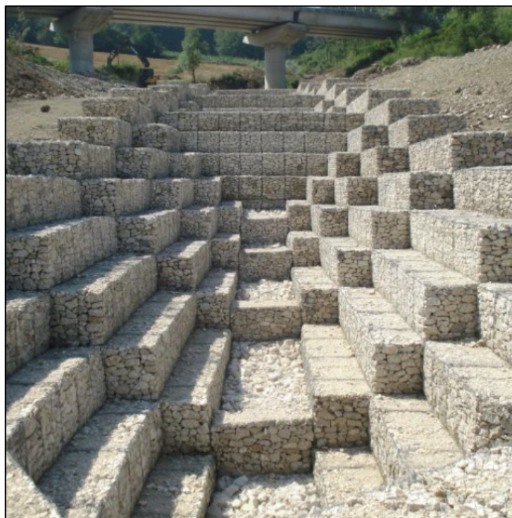
Slika 7.4. Odvodni kanali stabilizirani pomoću gabiona [94]
