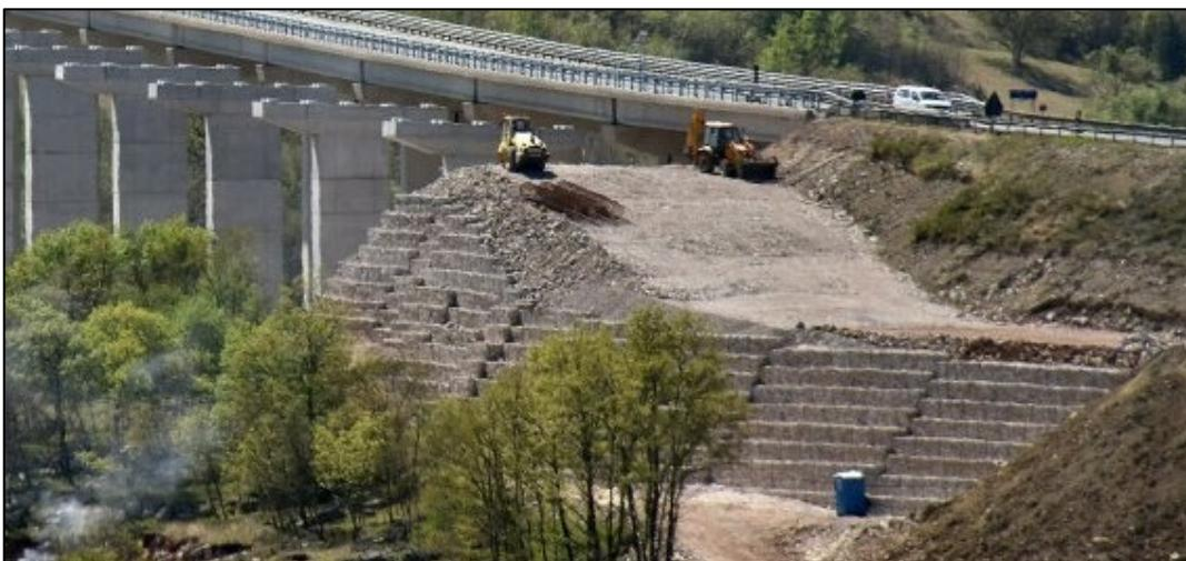
Slika 7.3. Potporni zid od gabiona s pletenom čeličnom mrežom – Istarski ipsilon – Mrzlići [93]
