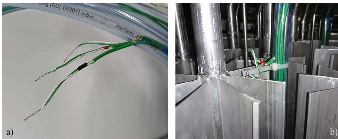
Slika 3.8. Postavljanje mjernih osjetnika u latentni spremnik topline, a) termoparovi u gumenoj cijevi, b) termoparovi učvršćeni plastičnim vezicama na pozicijama oko cijevi
