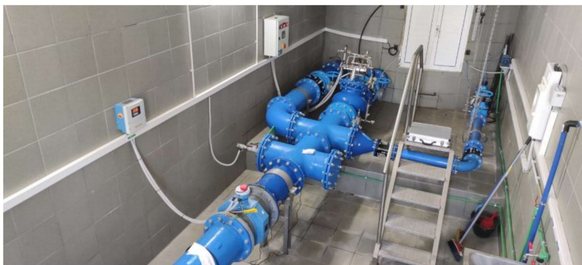
Slika 9: Unutrašnjost prekidne komore Luterija
