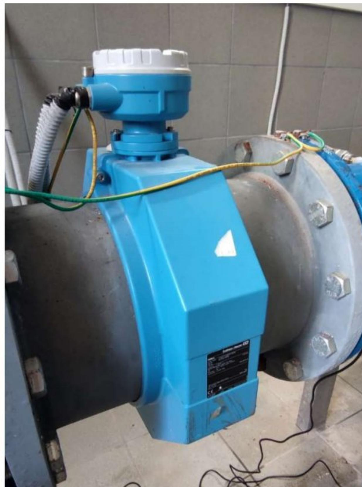
Slika 1: Elektromagnetski mjerač protoka Endress+Hauser
