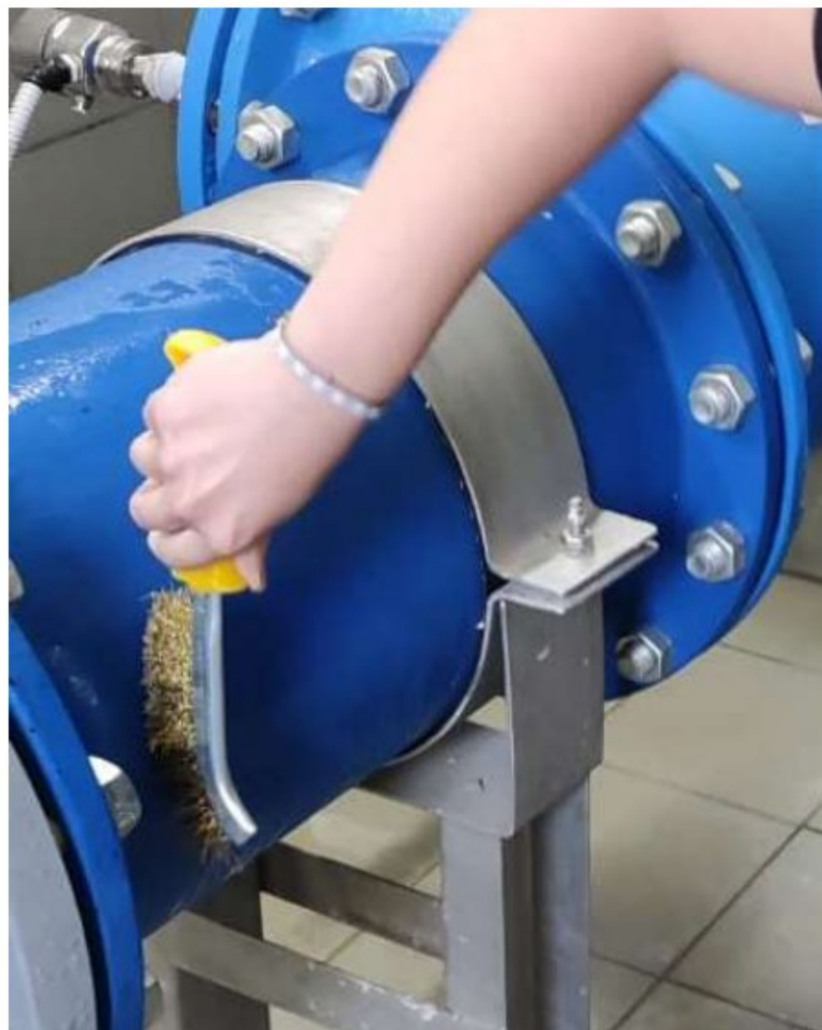
Slika 13: Ljuštenje boje sa cijevi
