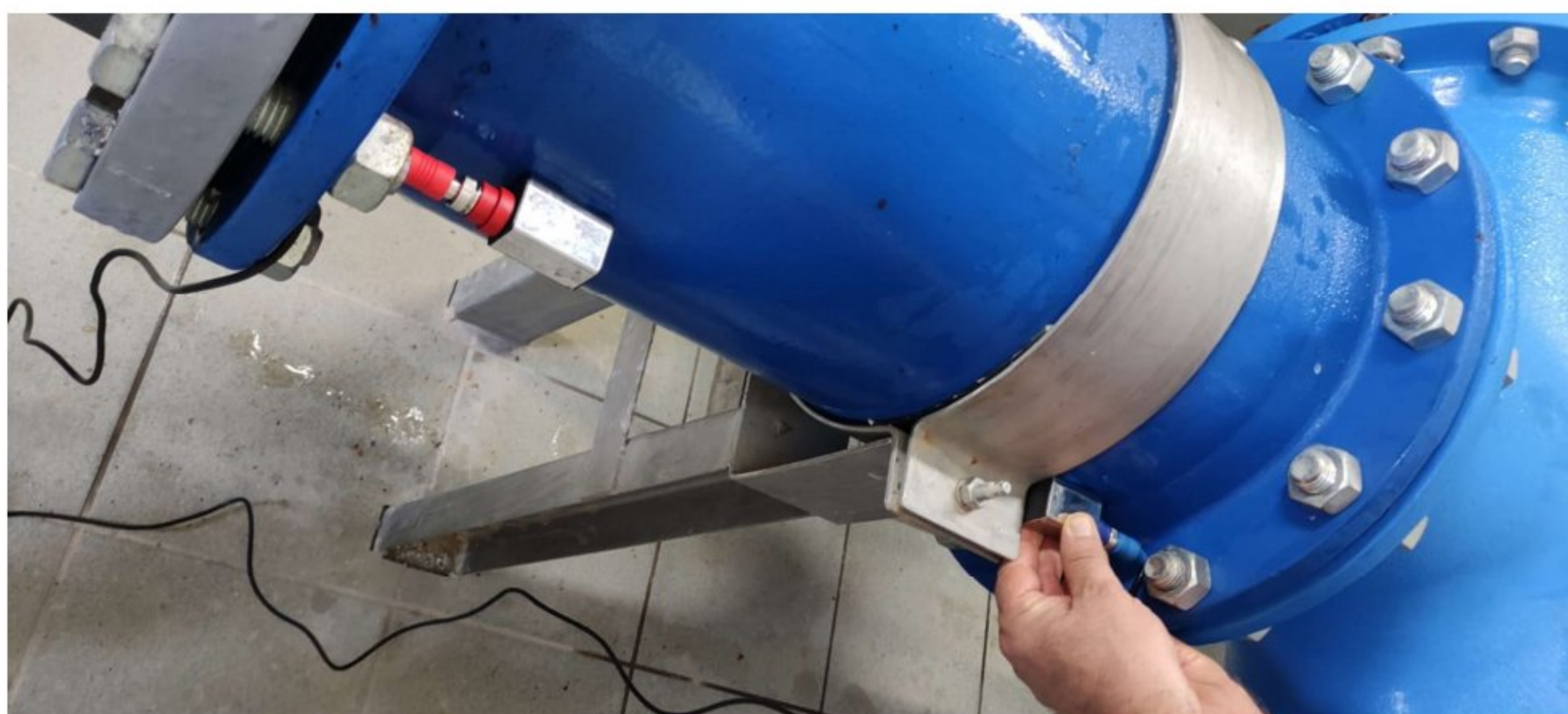
Slika 11: Postavljanje sonde na određenu udaljenost na cijev
