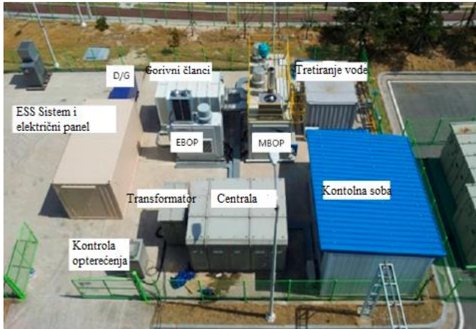
Slika 5.3. Testno hibridno postrojenje [109]
