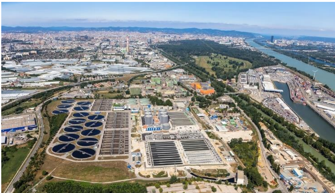
Slika 3.6 Postrojenje za pročišćavanje otpadnih voda u Beču [14]
