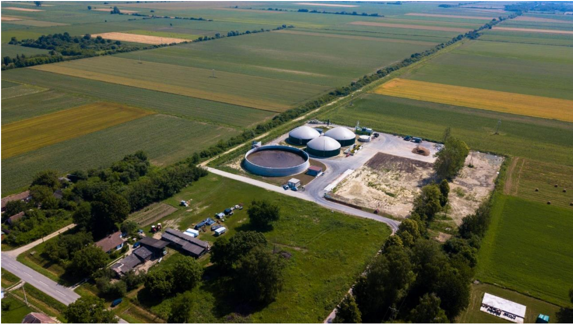
Slika 3.5 Centralno bioplinsko postrojenje u Viljevu u Osječko-baranjskoj županiji [13]
