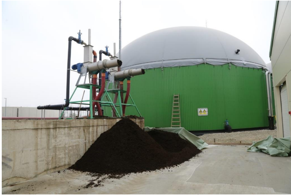
Slika 6.11 Vertikalni digestor s membranskim spremnikom bioplina [32]
