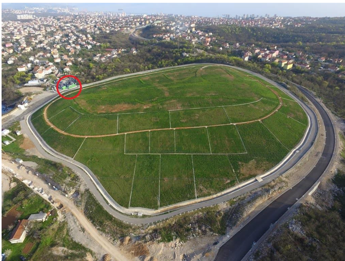
Slika 3.8 Bivše odlagalište otpada Viševac blizu Rijeke pretvoreno u digestor deponijskog plina [17]
