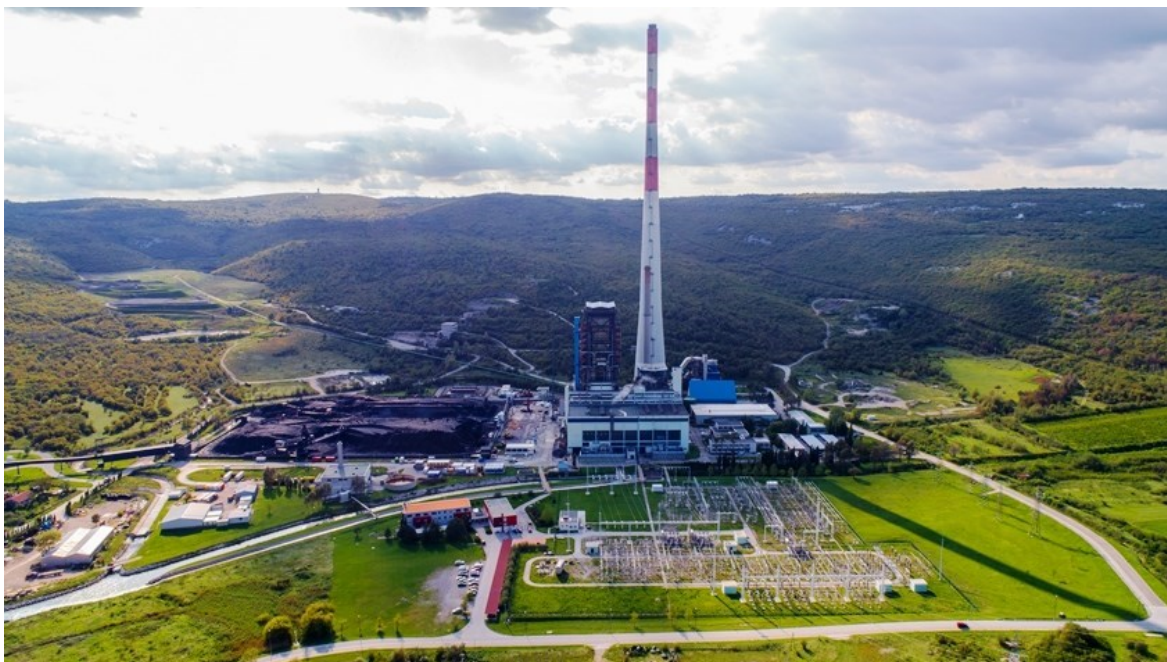
Slika 2.1. Postrojenje termoelektrane Plomin
