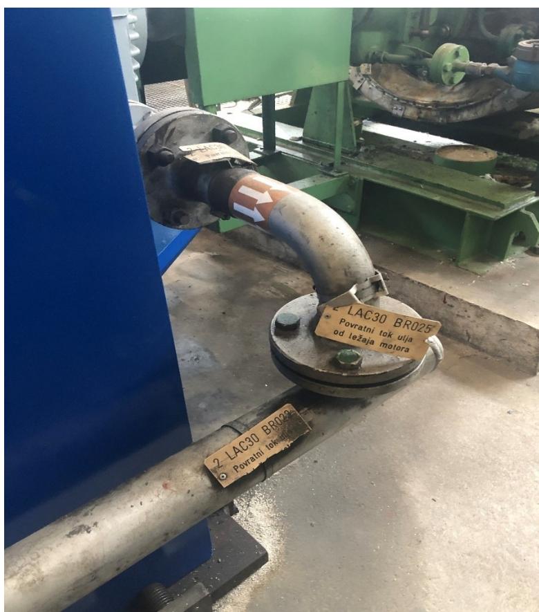
Slika 5.6. Prirubnica povratnog toka ulja kliznog ležaja
