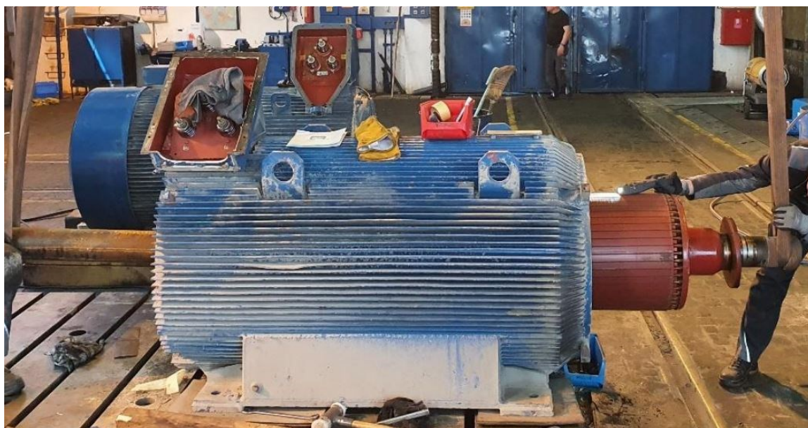
Slika 7.2. Vađenje rotora iz kućišta
