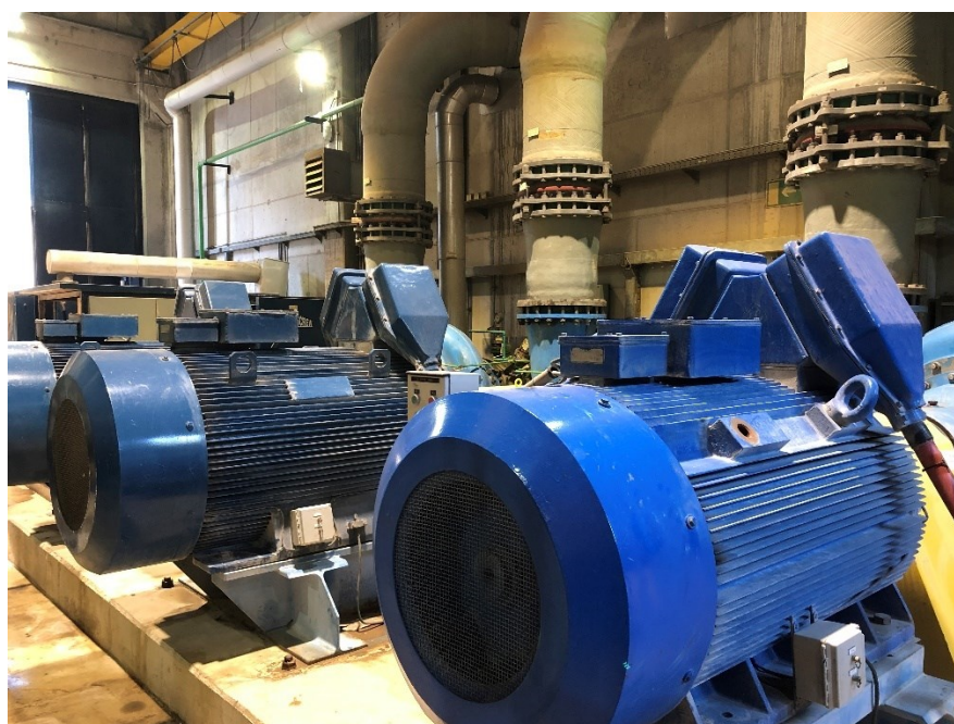
Slika 6.5. Elektromotori za pogon pumpi apsorbera
