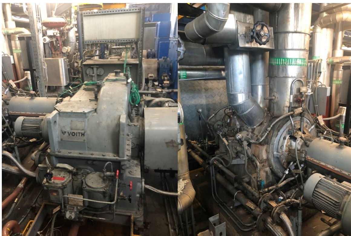
Slika 6.2. Hidraulička spojka i glavna napojna pumpa
