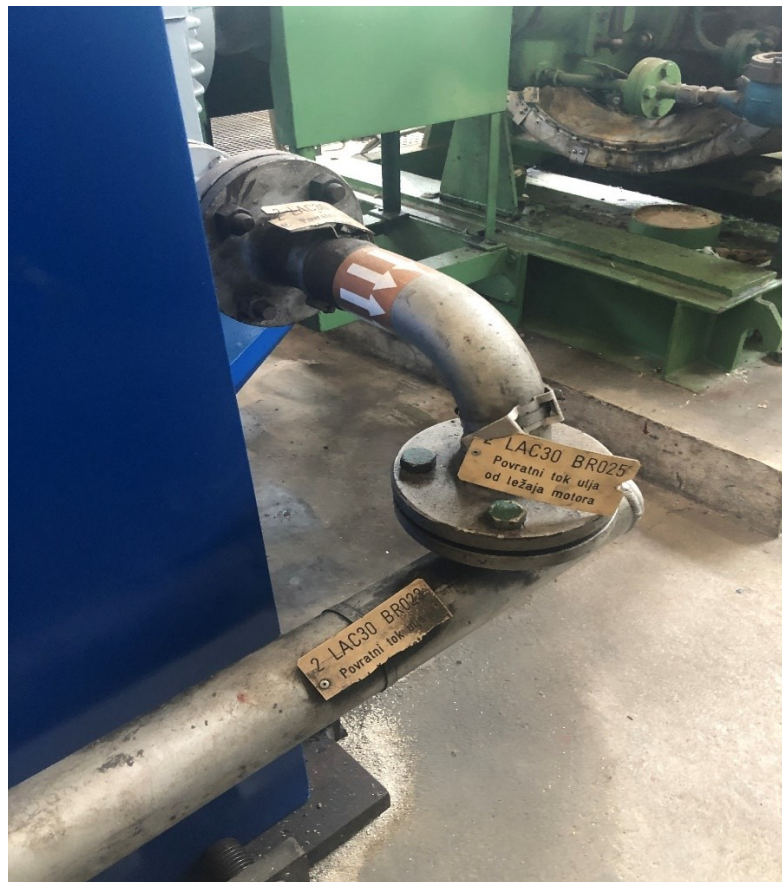
Slika 5.6. Prirubnica povratnog toka ulja kliznog ležaja
