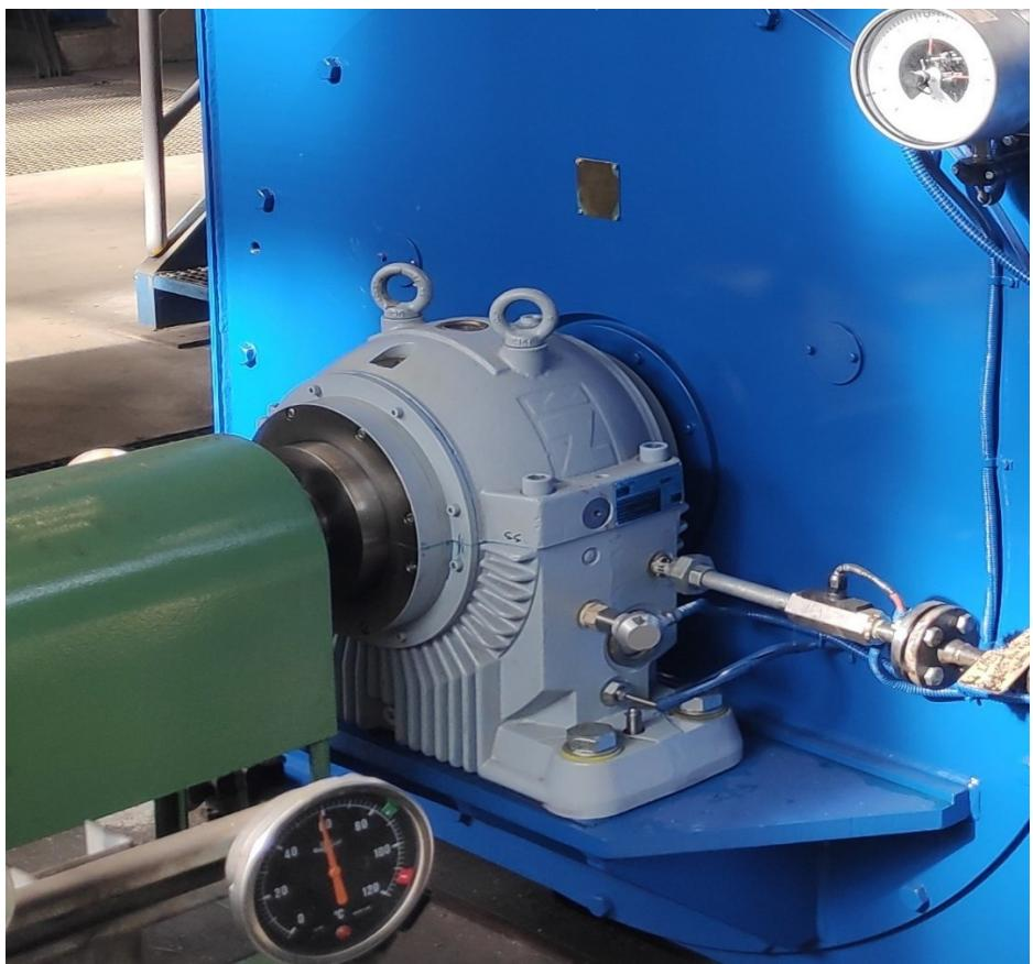
Slika 5.5. Klizni ležaj elektromotora napojne pumpe
