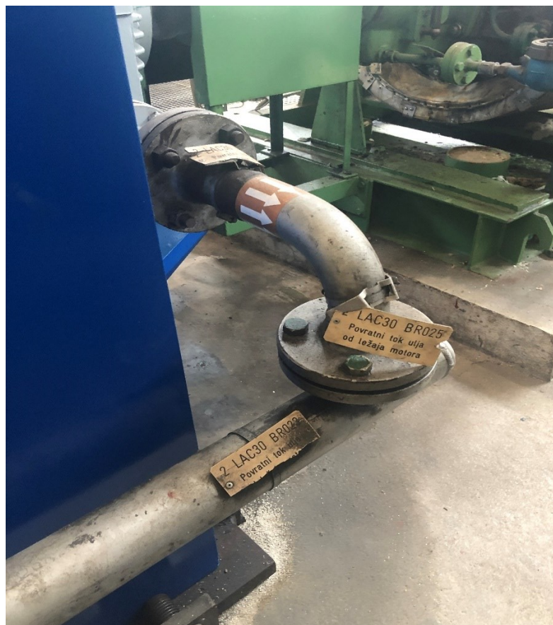
Slika 5.6. Prirubnica povratnog toka ulja kliznog ležaja
