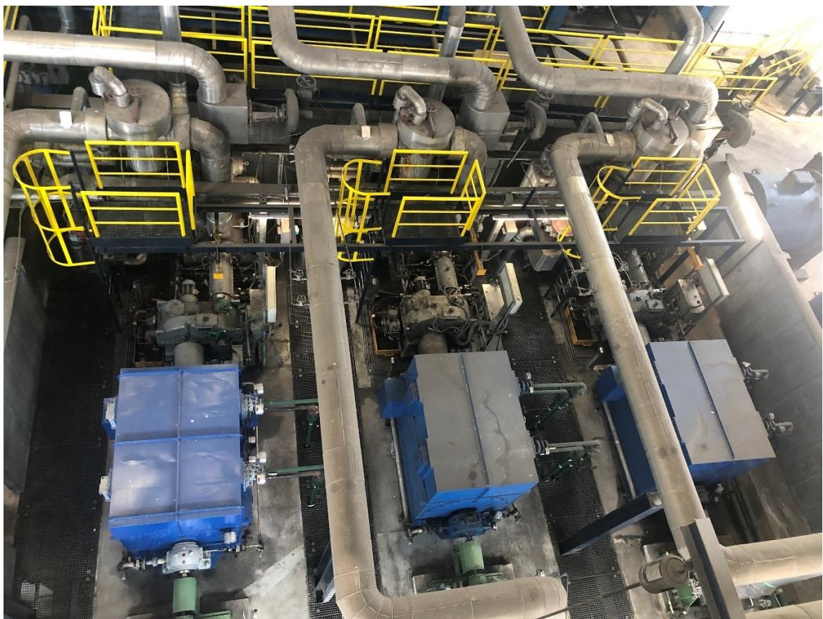
*Slika 6.1. Elektromotori napojnih pumpi svaki snage 4100 kW*
