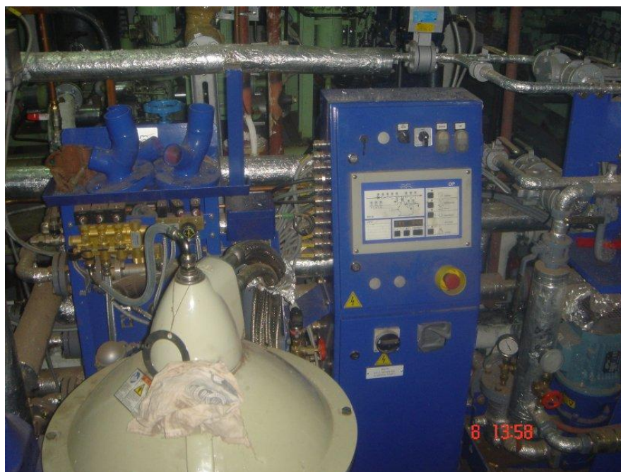
Slika 4.4 Modul separatora goriva u prostoriji separatora
