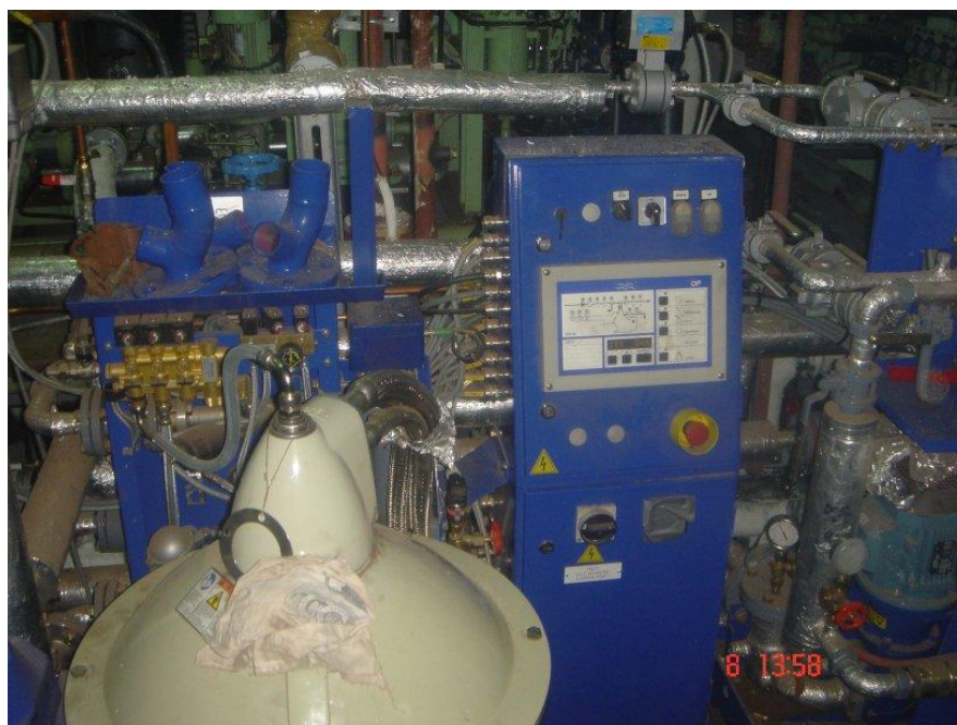
Slika 4.4 Modul separatora goriva u prostoriji separatora
