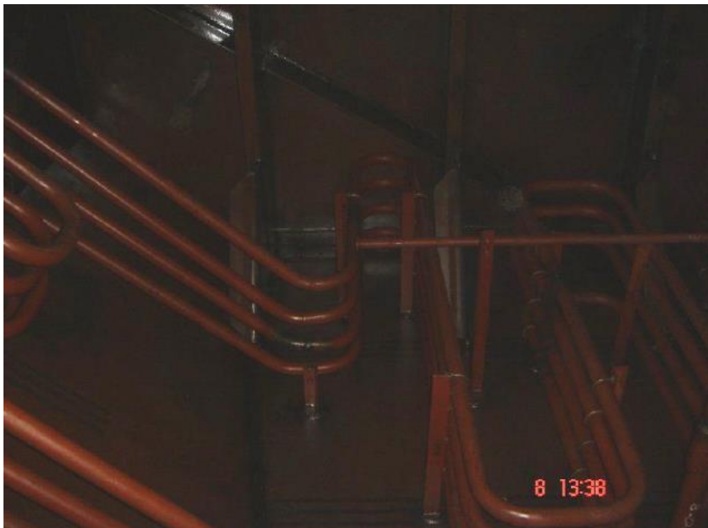
Slika 4.2 Unutrašnjost skladišnih tankova teškog goriva [1]
