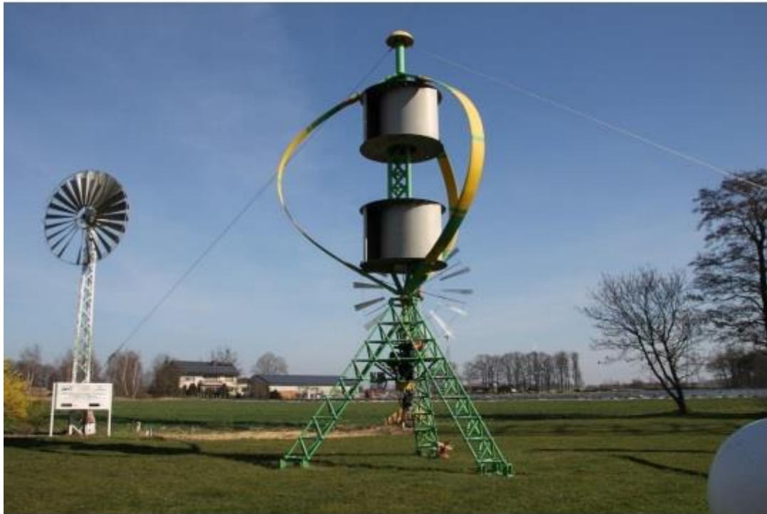
Slika 3.10. Hibridna Savonius-Darrieus vjetroturbina [10]
