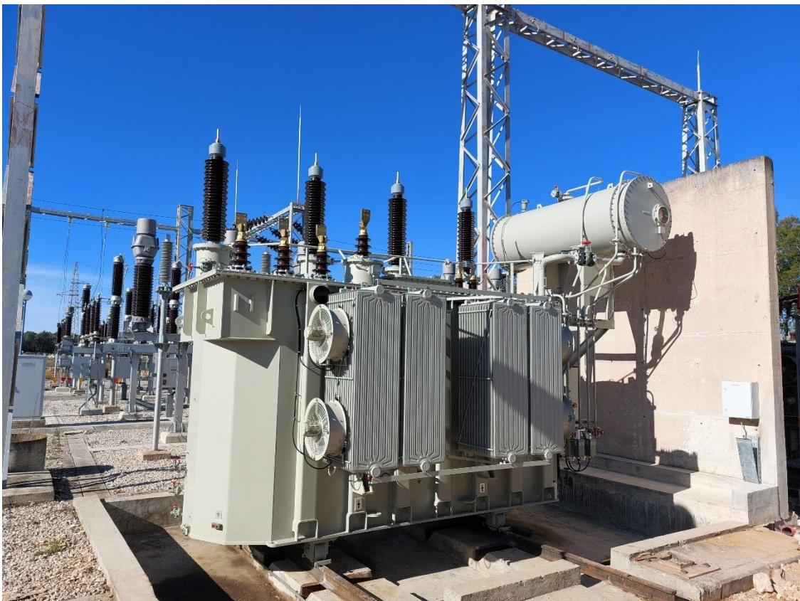
*Slika 2.4. Energetski transformator nazivnog napona 110/10,5(21) kV tvrtke KONČAR
