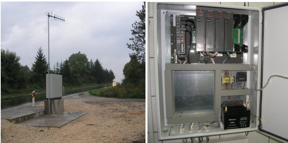
*Slika 5.7. Lijevo RTU ormarić na otvorenom, desno oprema ormarića [12]*
