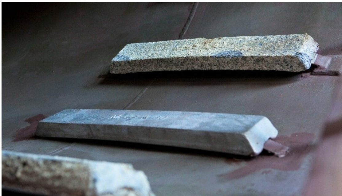
Slika 3.9. Žrtvujuća anoda [45]
