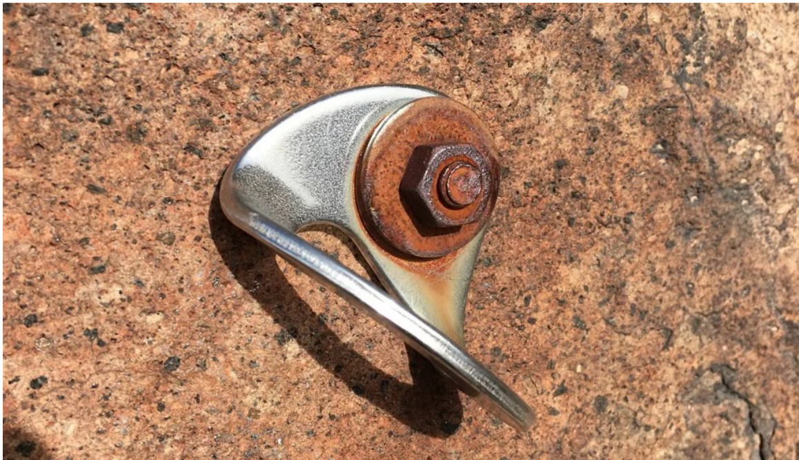
Slika 2.19. Primjer galvanske korozije [22]
