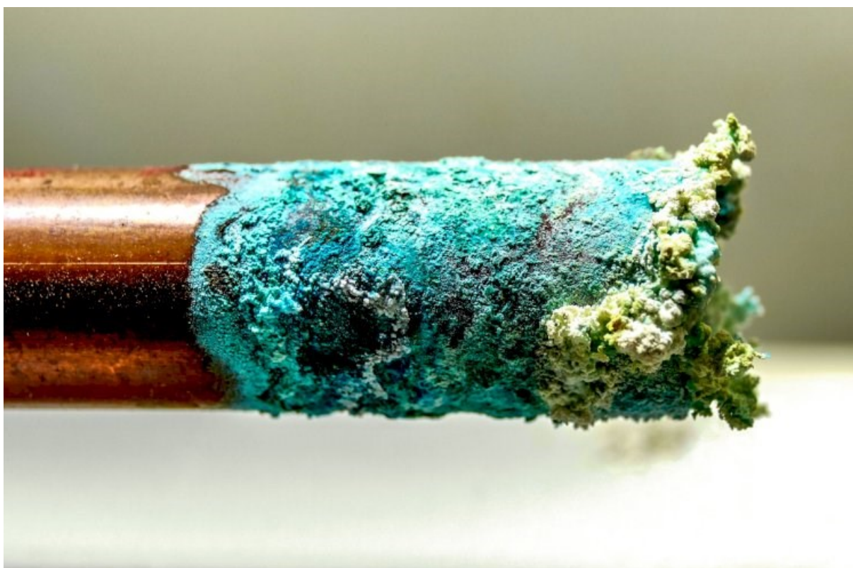
Slika 2.8. Korozija bakrene cijevi [12]
