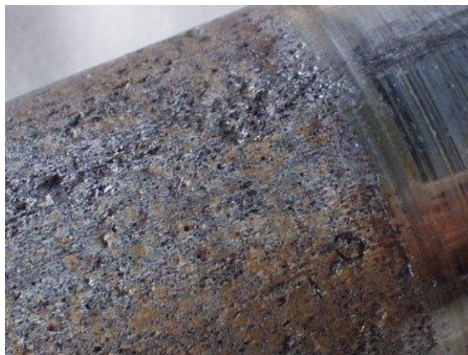
Slika 3.22. Korozija vanjske površine cijevi nastala djelovanjem lutajućih struja [43]
