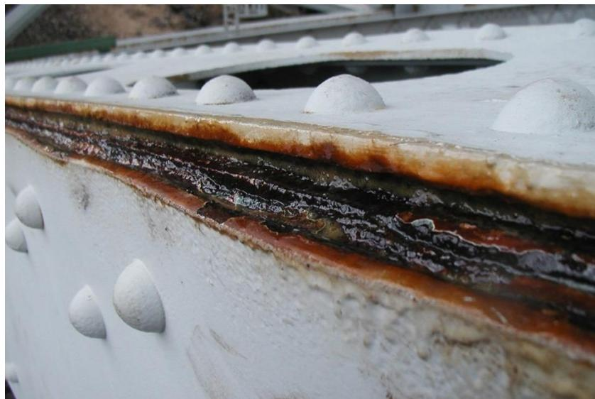
Slika 3.10. Korozija u procijepu na spoju dva metalna dijela konstrukcije
