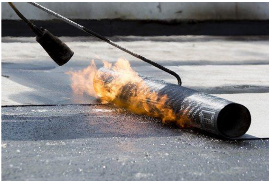
Slika 4.6. Bitumenizacija ravnog krova [47]
