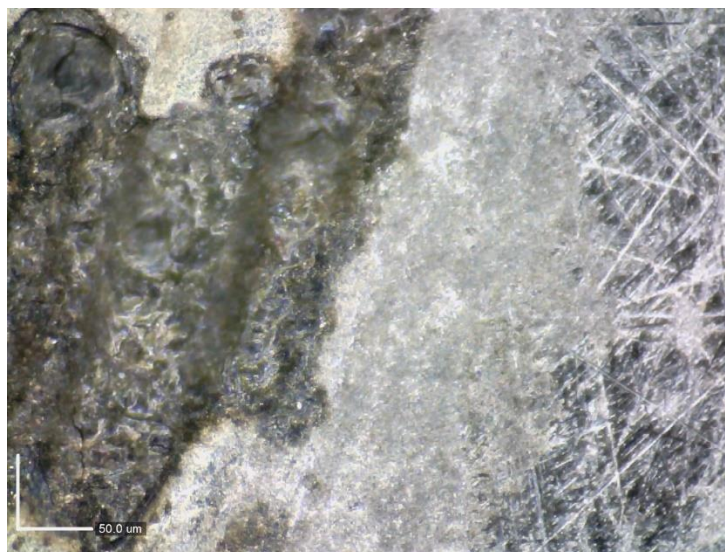
Slika 6.23. Prijelaz između brušene i korodirane površine cementiranog uzorka
