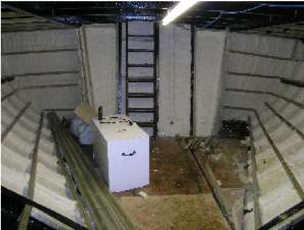
Slika 3.12 Postavljene drvene gredice, [5]
