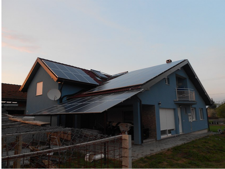
Slika 4.5 Prikaz montaže fotonaponskih solarnih panela [11]
