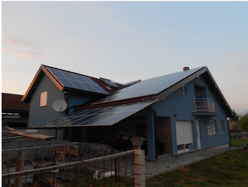
Slika 4.5 Prikaz montaže fotonaponskih solarnih panela [11]
