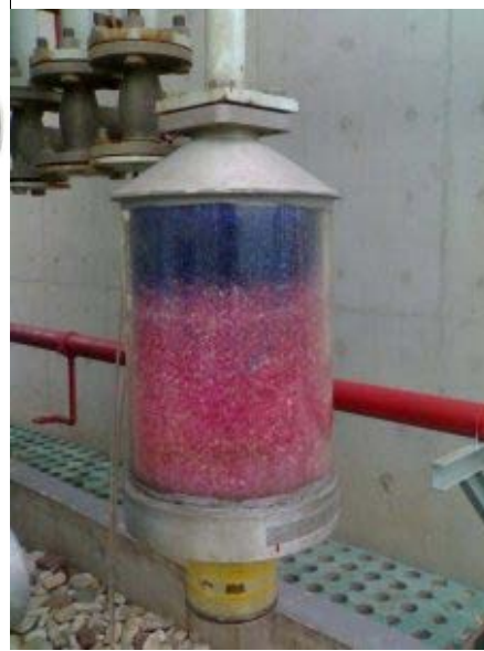
Slika 2.7. Istrošeni silikagel
