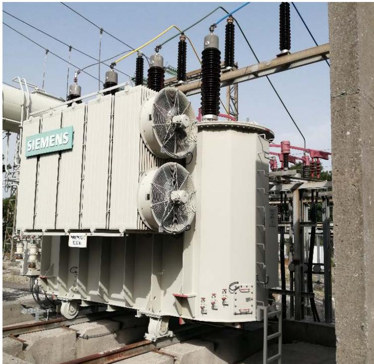
*Slika 2.4. Transformator sa sustavom za prisilno hlađenje ulja zrakom*
