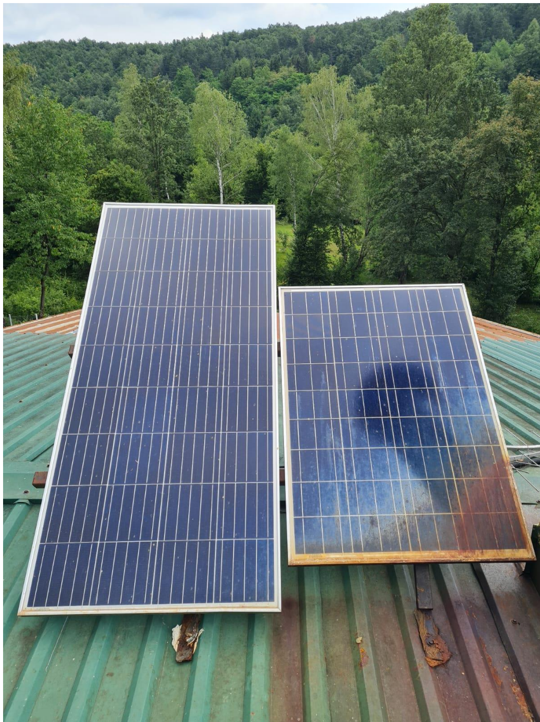
Slika 7.1 Polikristalni solarni paneli
