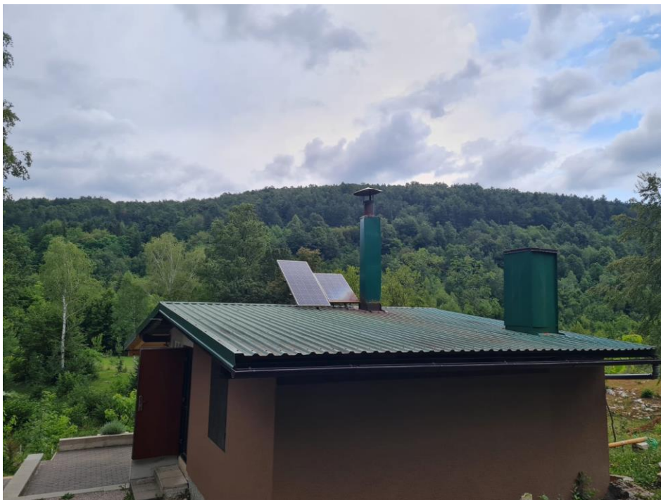
Slika 4.1 Kuća za odmor za solarnim panelima
