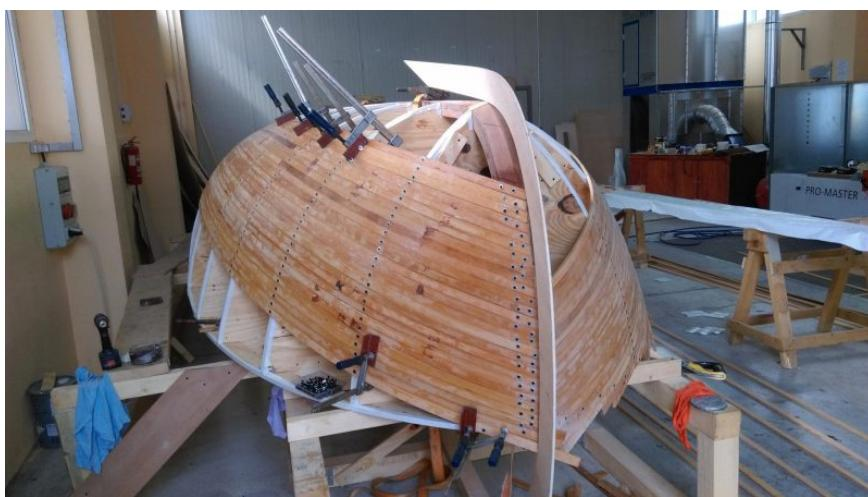
*Slika 2.5 Izrada oplate metodom letvica [5]*
