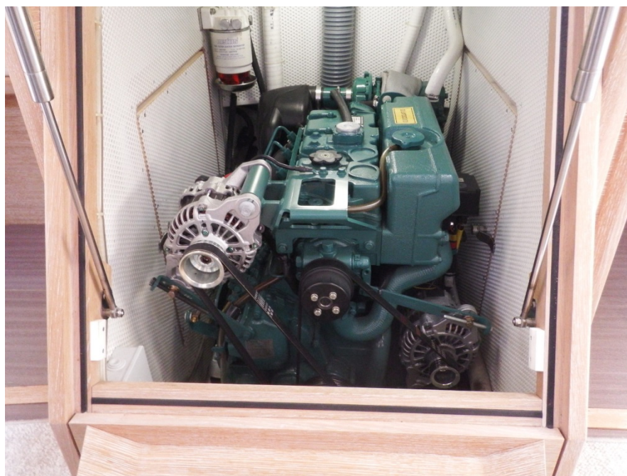
Slika 3.7.1.: Postavljanje motora unutar jedrilice ispod stepeništa (ulaza u glavni salon)
