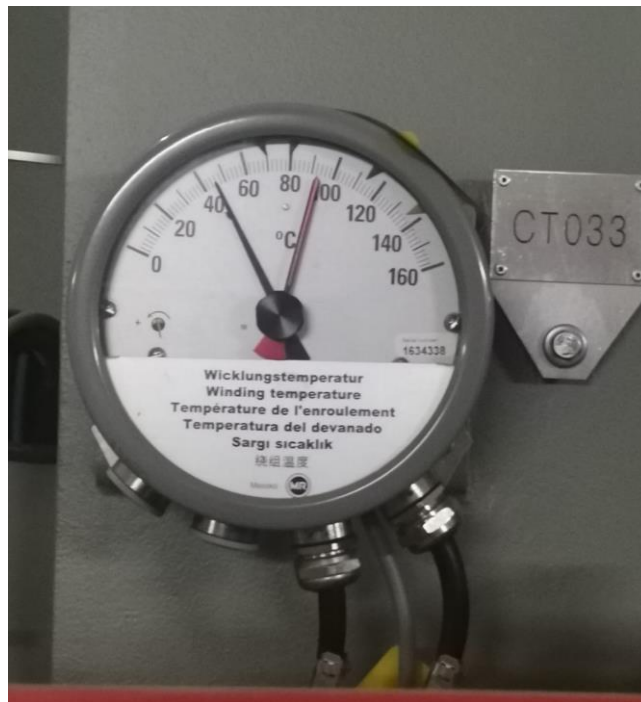
Slika 3.3. Prikaz kontaktnog termometra
