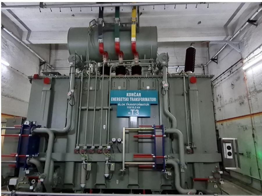
*Slika 2.1. Energetski transformator 110/10,5 kV u HE Senj*
