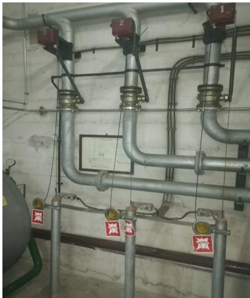
Slika 3.6. Prikaz Argus ventila
