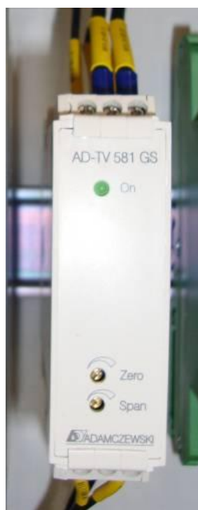
Slika 5.4. Pretvornik za mjerenje struje tereta transformatora – AD TV 581 GS [12]
