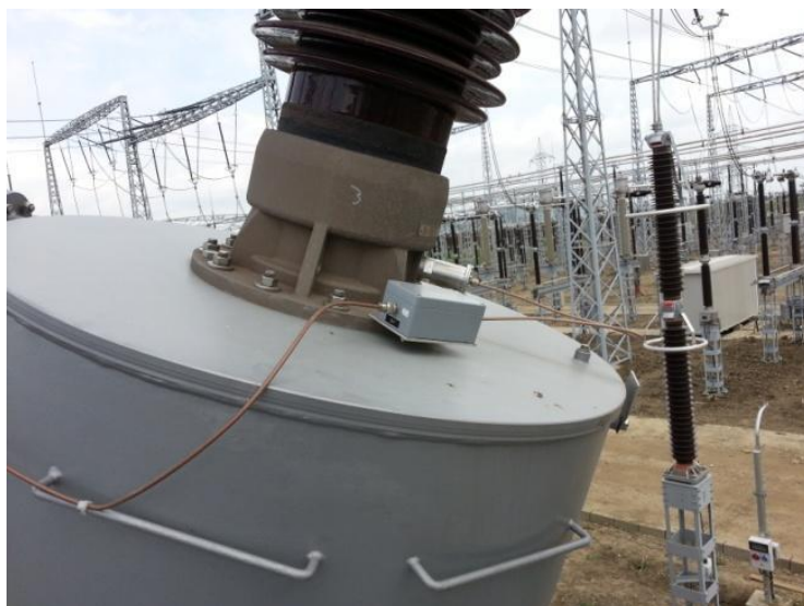
Slika 5.3. Mjerna impedancija s adapterom za monitoring provodnika – VDB [12]
