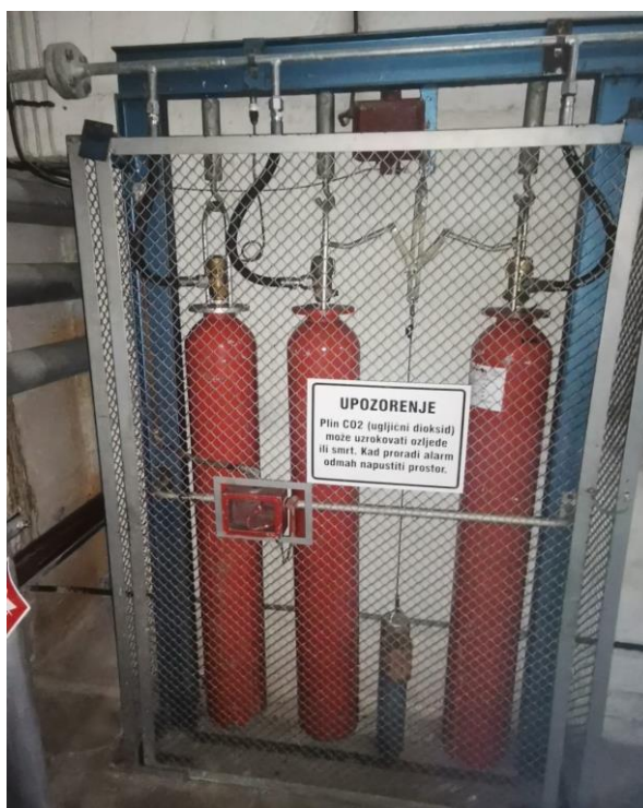
Slika 3.7. Prikaz CO2 boca za gašenje požara
