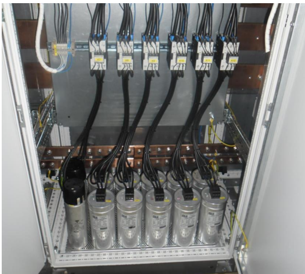
Slika 3.4. Kompenzacija u vodnom polju zajedno sa sklopnicama [6]
