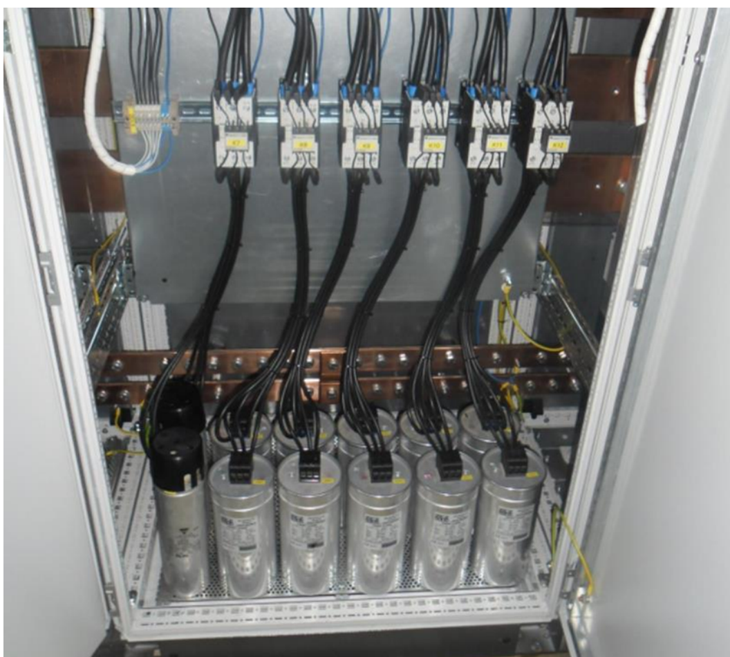
Slika 3.4. Kompenzacija u vodnom polju zajedno sa sklopnicama [6]
