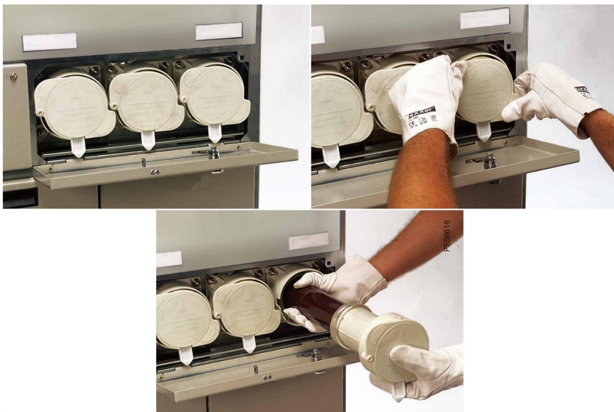
Slika 6.9. Prikaz zamjene osigurača u sklopnom bloku. Izvor: [11]
