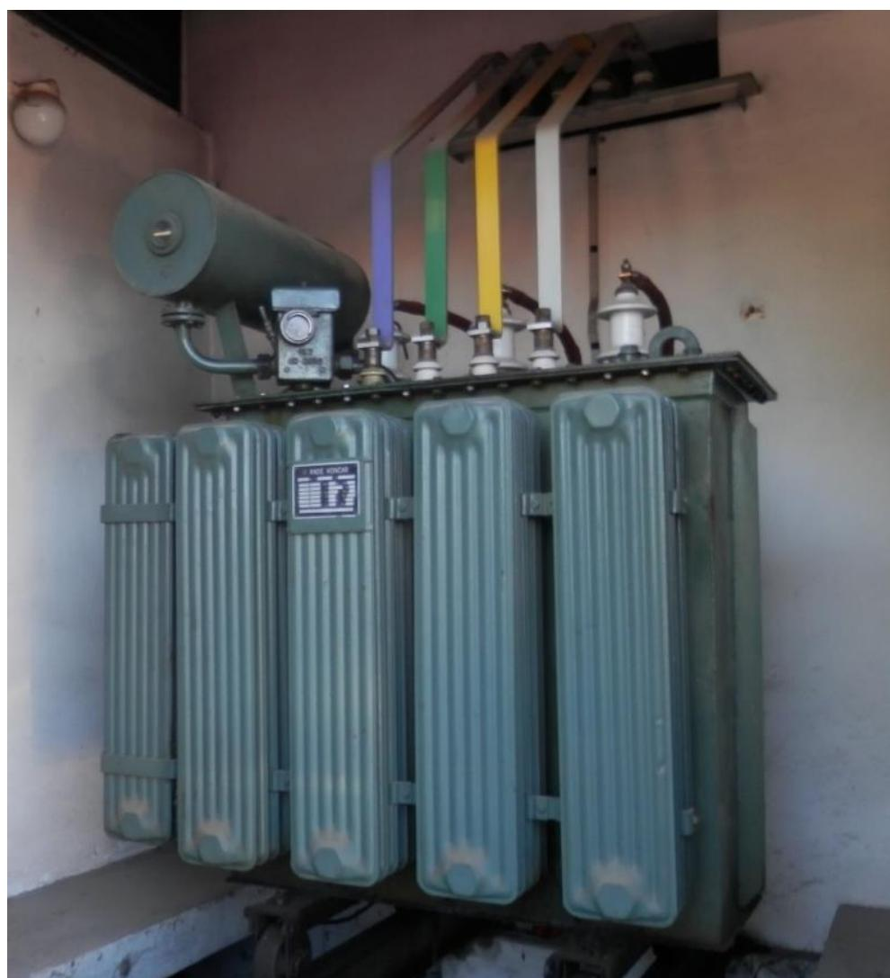
Slika 5.7. Stara izvedba transformatora snage 400 kVA.
