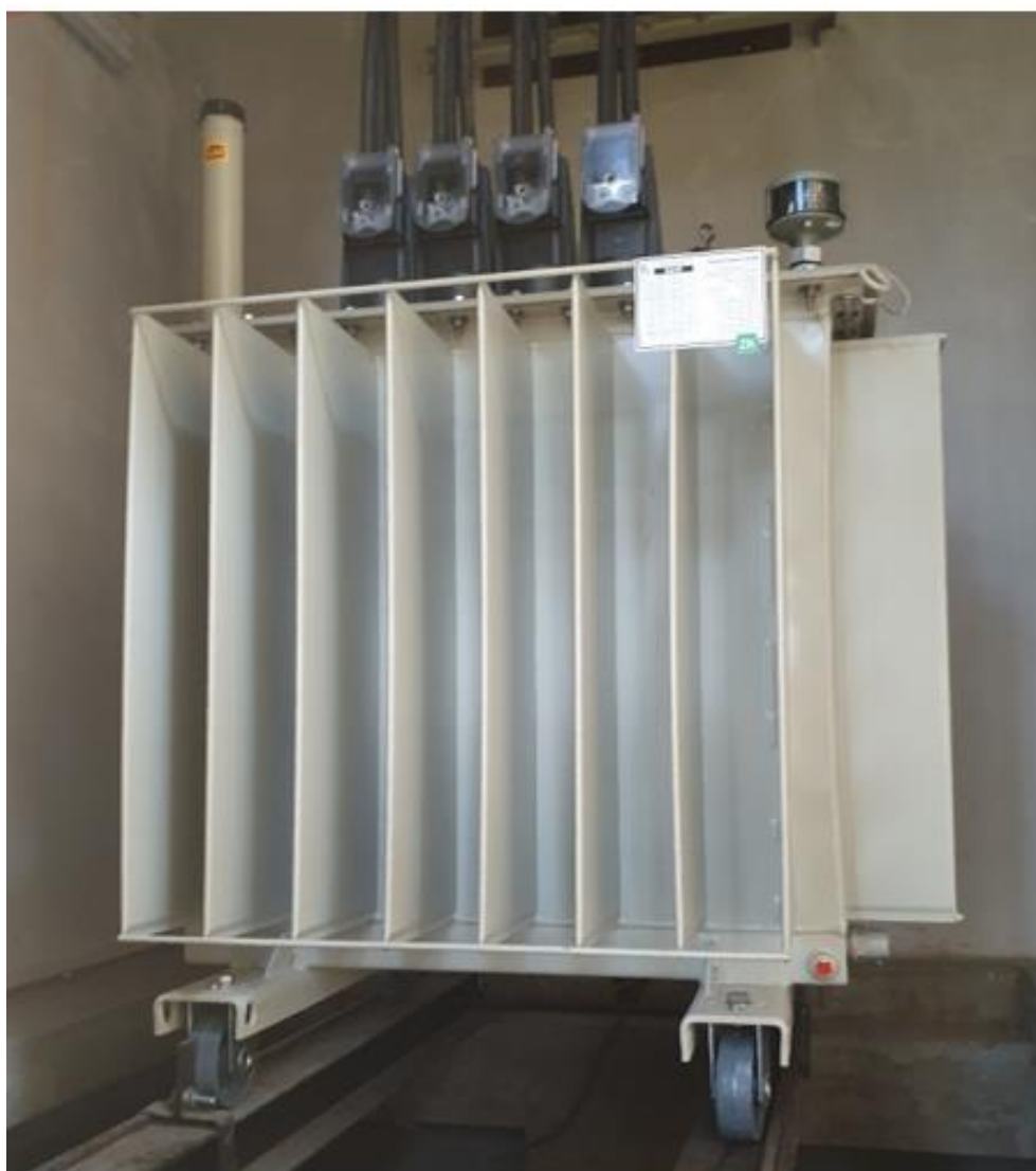
Slika 5.8. Nova izvedba transformatora snage 400 kVA.
