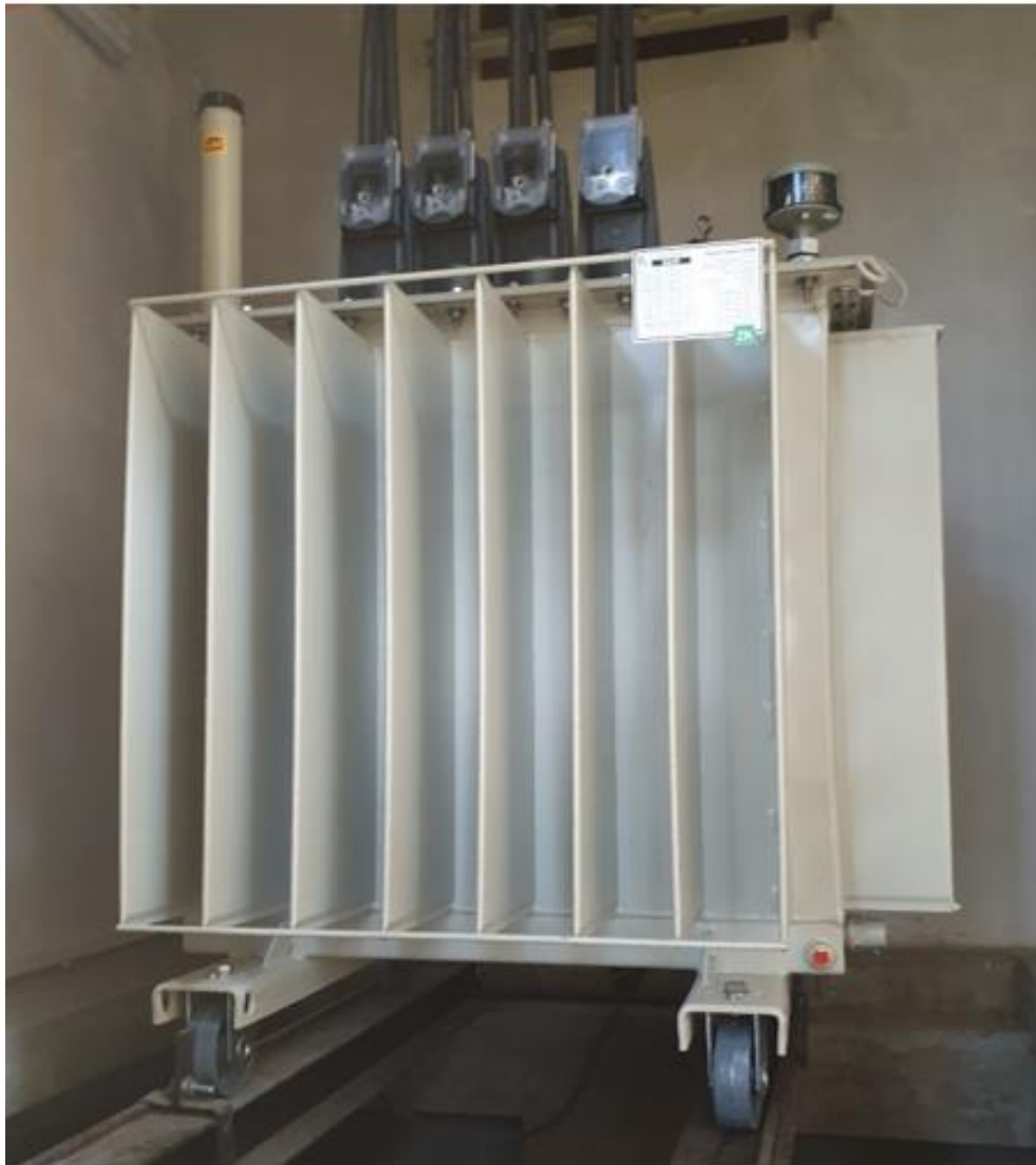
Slika 5.8. Nova izvedba transformatora snage 400 kVA.
