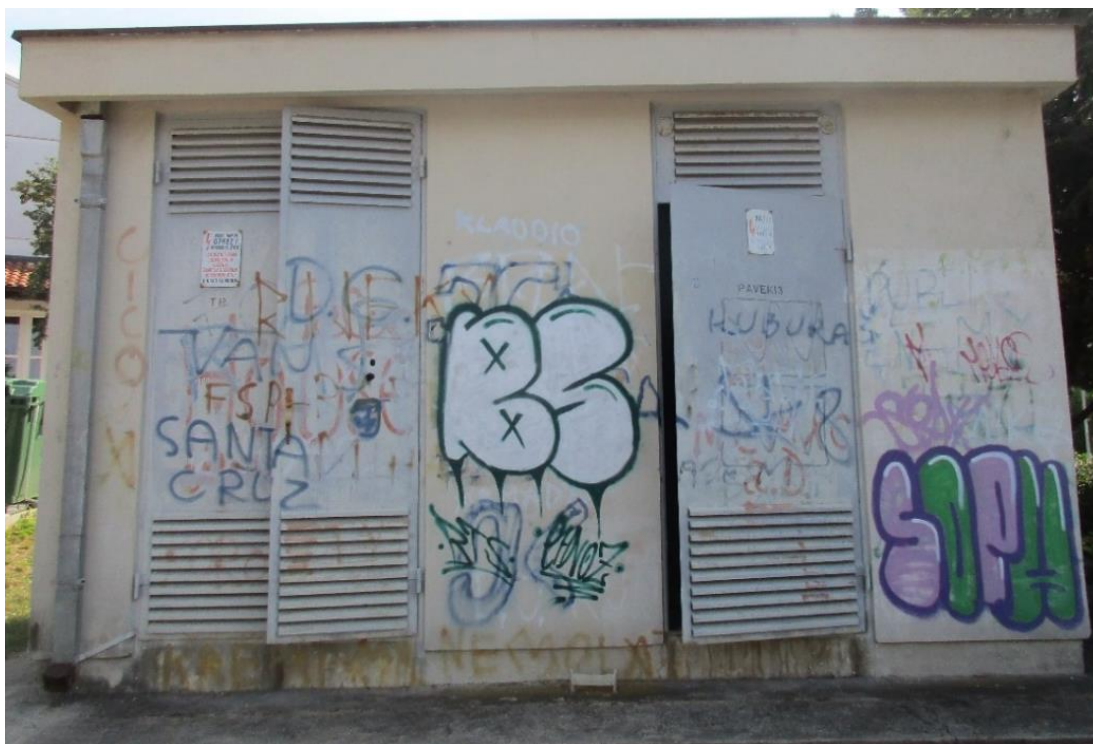
Slika 4.15. Prikaz TS gradskog tipa G1 - TS Paveki.
