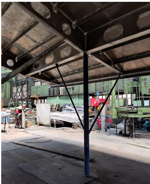
Slika 10.1. Upore oko stupova
