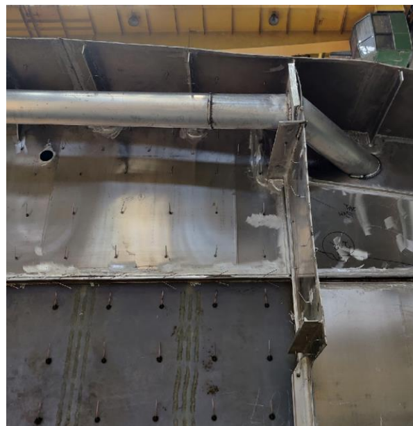
Slika 10.1. Upora na aluminijskoj strukturi
