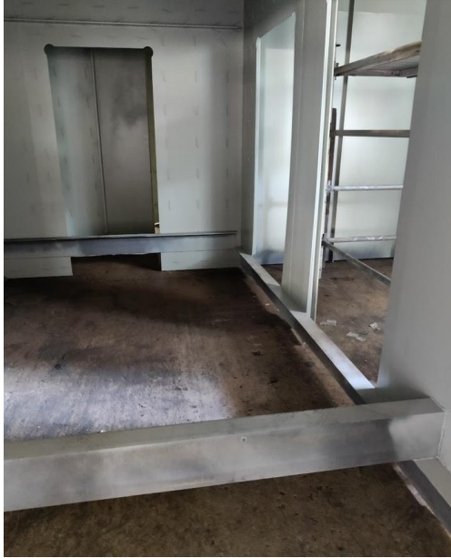
Slika 10.3. HP profili kao upore
