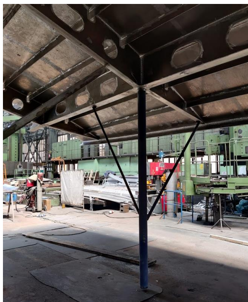
Slika 10.1. Upore oko stupova
