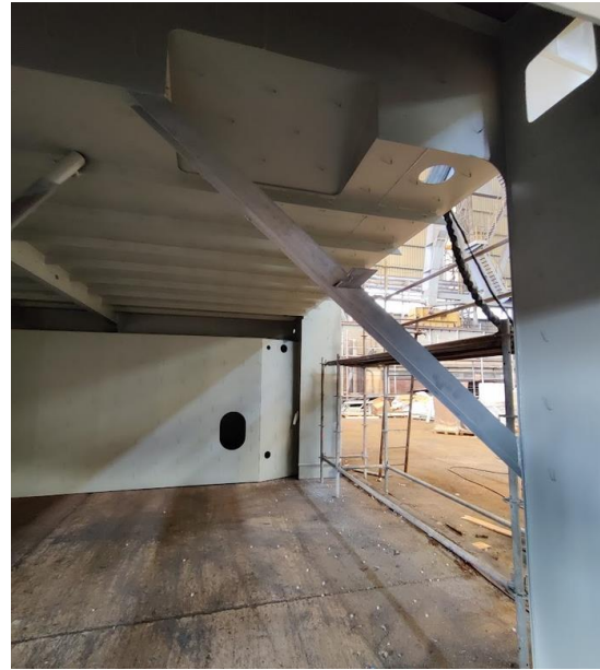
Slika 10.4. Upore na sredini sekcije
