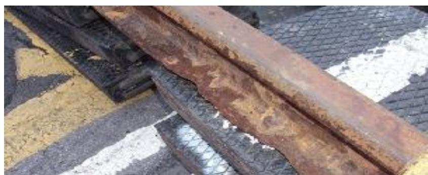
Slika 5.26. Korozija lutajućih struja na tračnicama [50]
