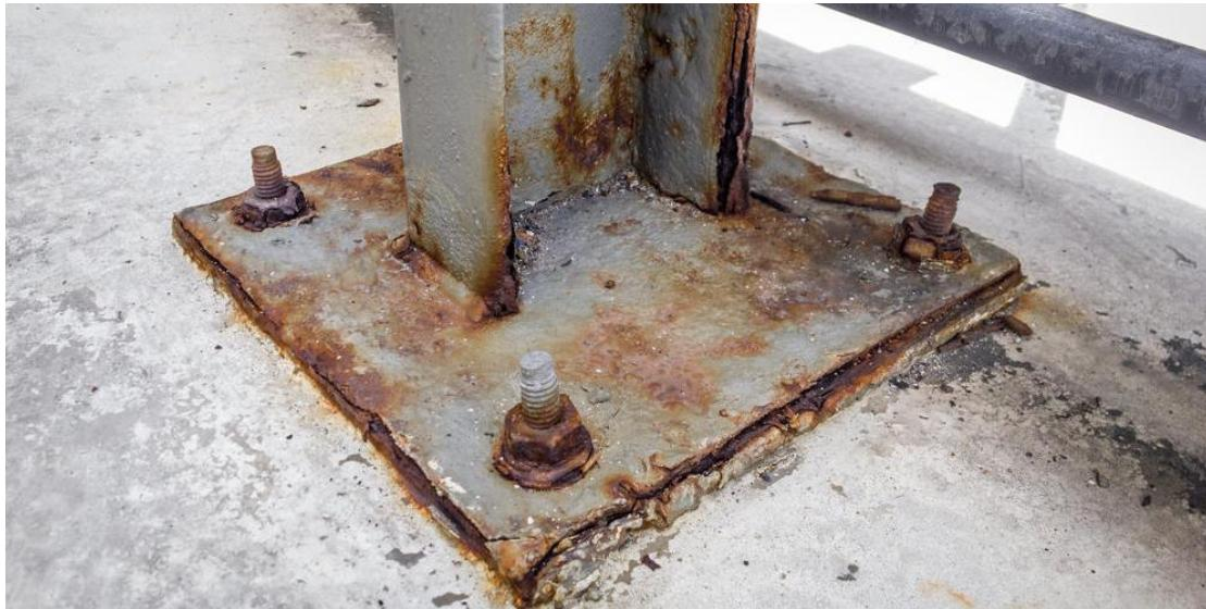
Slika 5.24. Korozija u procijepu kod čeličnog stupa [47]
