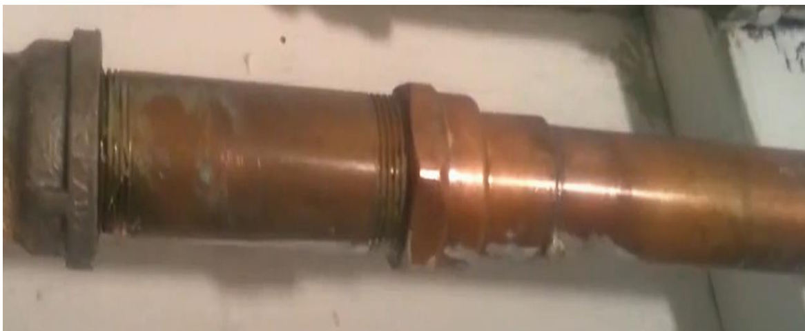
Slika 5.30. Pravilno spojene cijevi od različitih materijala [53]
