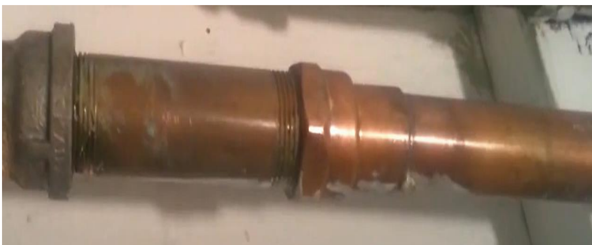
Slika 5.30. Pravilno spojene cijevi od različitih materijala [53]
