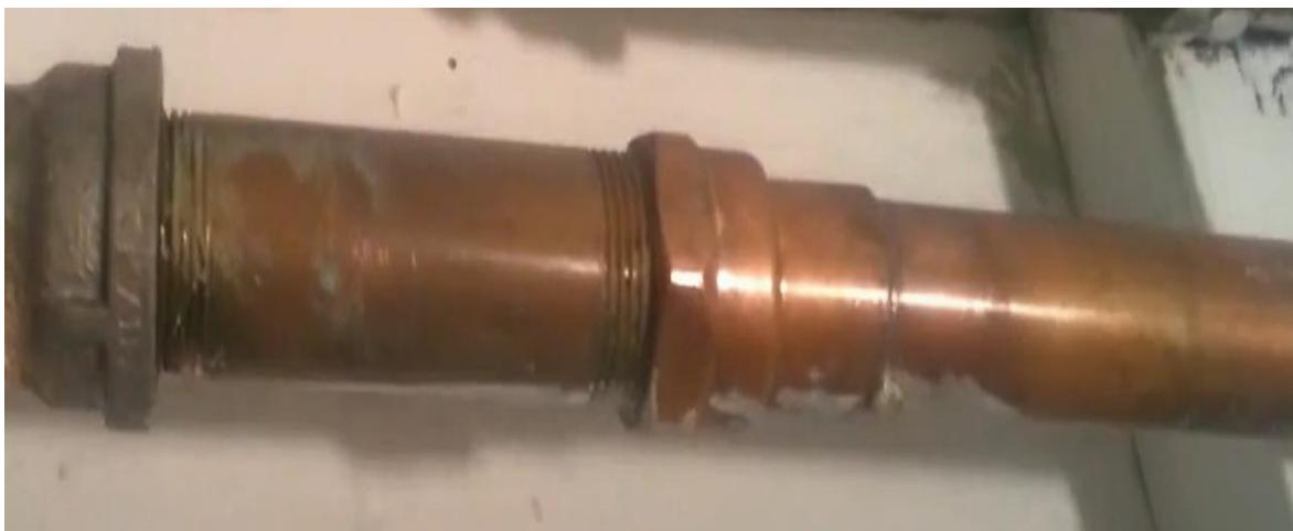
Slika 5.30. Pravilno spojene cijevi od različitih materijala [53]
