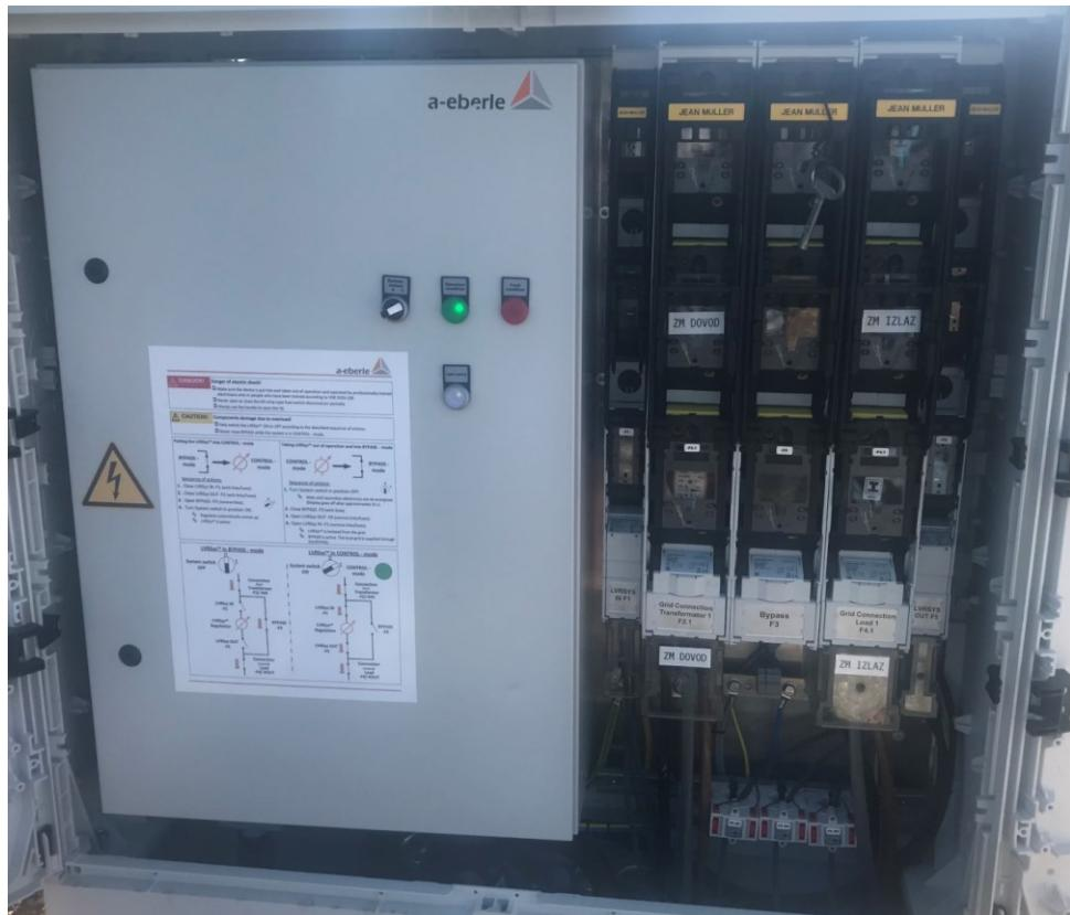
Slika 8.2. LVR<sub>Sys</sub> stabilizator napona u ormariću
