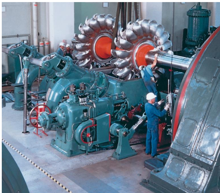
Slika 3.9. Montaža višerotorske Peltonove turbine [10]
