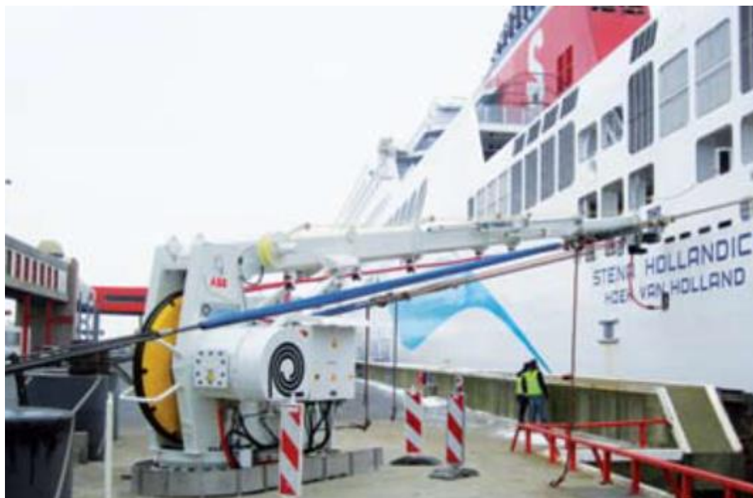
Slika 4.2 Priključenje broda Stena Hollandica na kopneni priključak [15]
