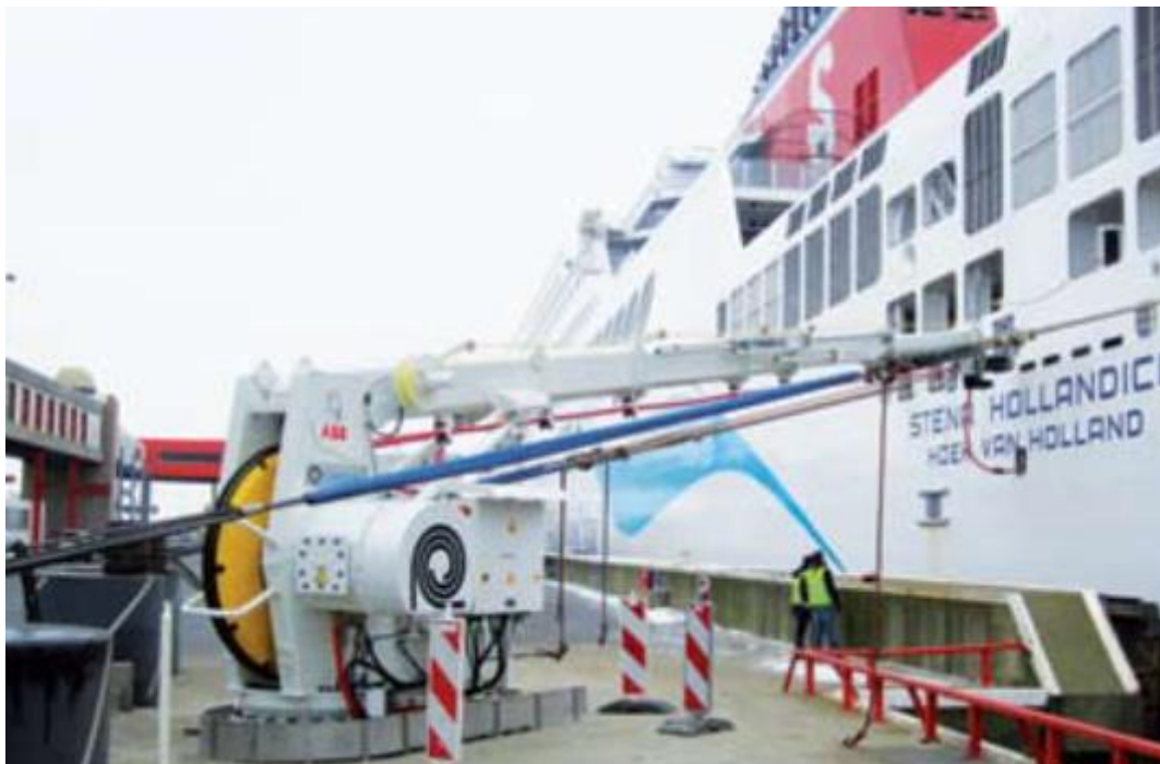
Slika 4.2 Priključenje broda Stena Hollandica na kopneni priključak [15]
