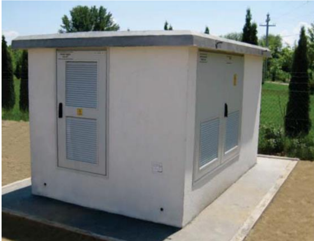
Slika 5.6 Primjer TS 20(10)/0.4 kV, 630 kVA [21]
