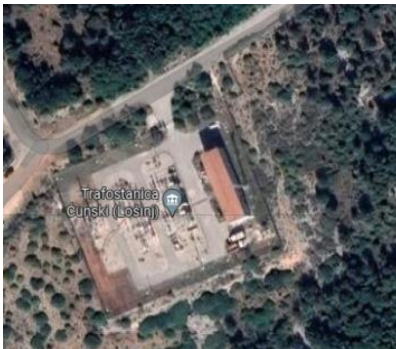
Slika 10.2. TS 110/35 kV Lošinj [24]
