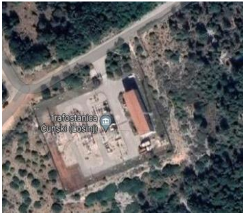
Slika 10.2. TS 110/35 kV Lošinj [24]
