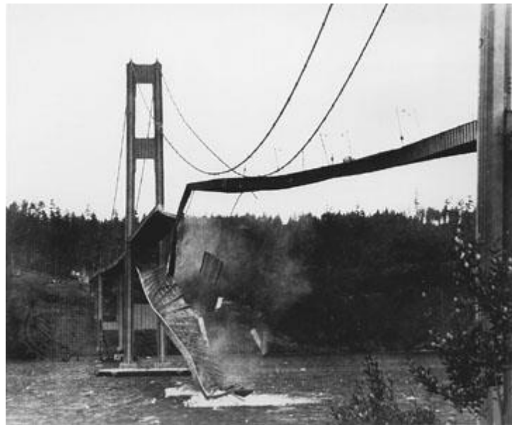
Slika 2.7 Urušavanje Tacoma Narrows Bridge-a [4]
