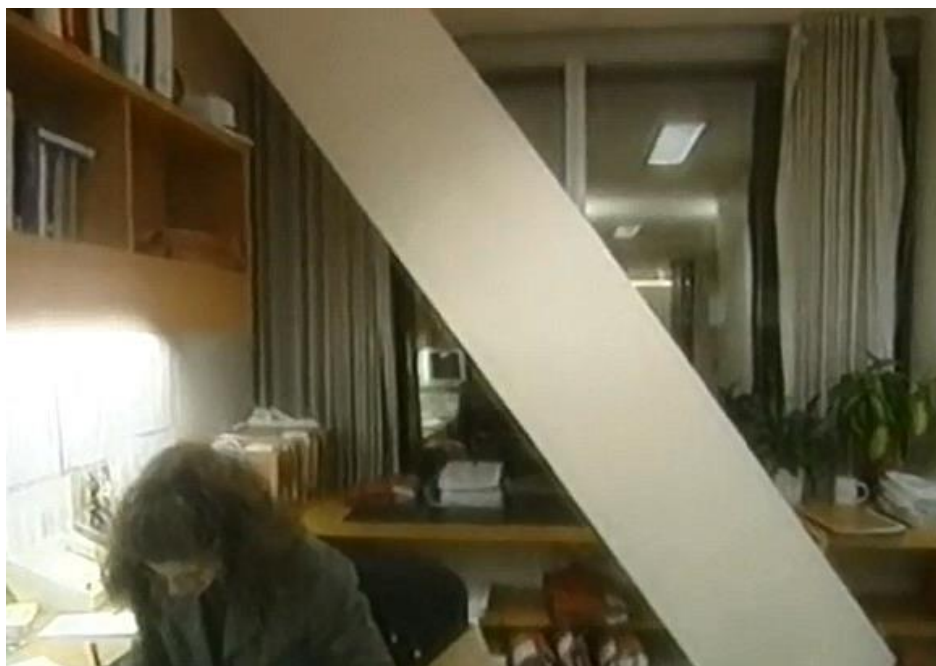
Slika 2.9 Krak v-spoja unutar nebodera [6]
