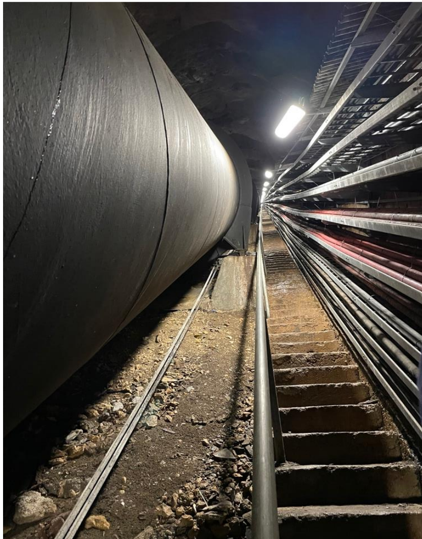
Slika 3.5. Tlačni cjevovod HE Rijeka
